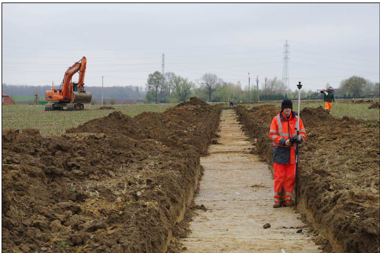
Afbeelding 5: topografisch inmeten van de proefsleuven.
