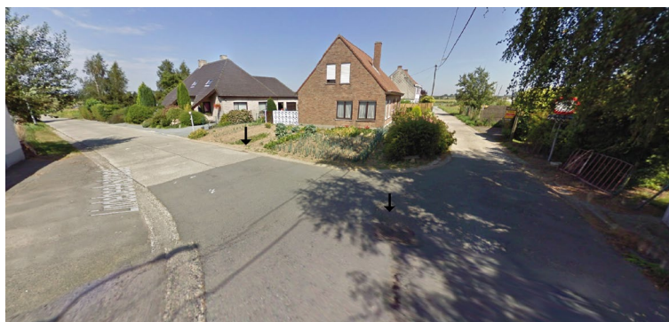
Foto 7 Kruispunt van de Windmolenstraat en de Lindebeekstraat met aanduiding van bestaande riolering. Zicht naar het noorden.
