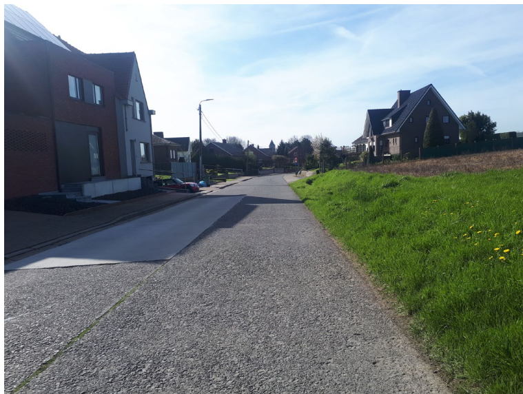
Foto 21 De Opstalstraat ter hoogte van het meest noordelijke punt van het projectgebied, zicht naar het zuiden (14 april 2023) : links en rechts zijn de taluds te zien waarbinnen de rijweg zich bevindt.
