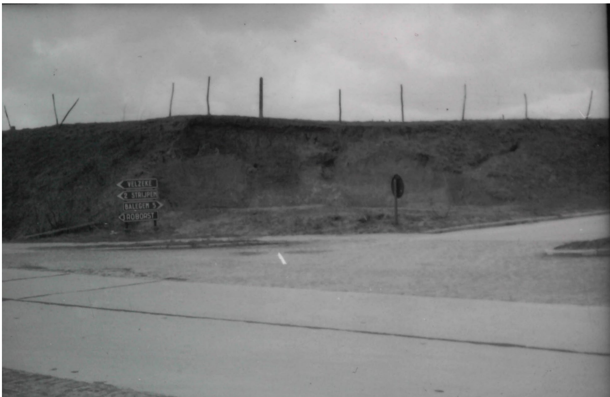
Foto 24 Foto tijdens de grondwerken voor de aanleg van kruispunt van de N46 met de Opstal- en de Lieve Heerstraat (Bron : Archeocentrum Velzeke). Op deze foto is een profiel op het talud naast de rijweg zichtbaar, met daarin vastgestelde Romeinse sporen.
