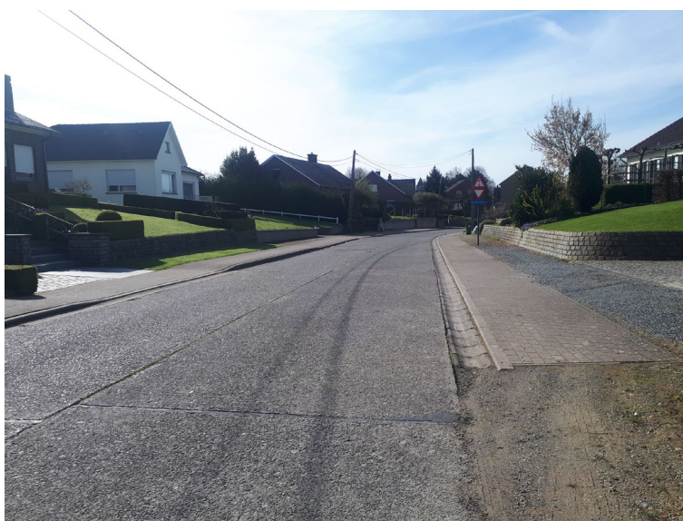
Foto 19 De Opstalstraat in de richting van de N46 (14 april 2023) : links en rechts zijn de taluds te zien waarbinnen de rijweg zich bevindt.
