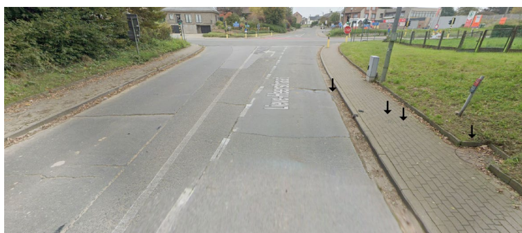
Foto 10 Lieve Heerstraat met aanduiding van bestaande nutsleidingen en riolering. Zicht naar de N46.
