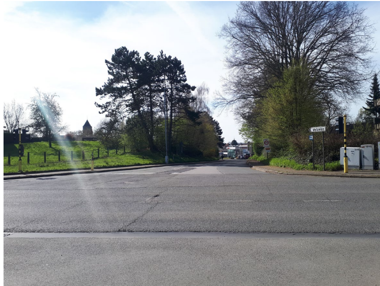
Foto 22 Zicht vanaf de N46 naar de Lieve Heerstraat (14 april 2023) : links en rechts zijn de taluds te zien waarbinnen de rijweg zich bevindt.
