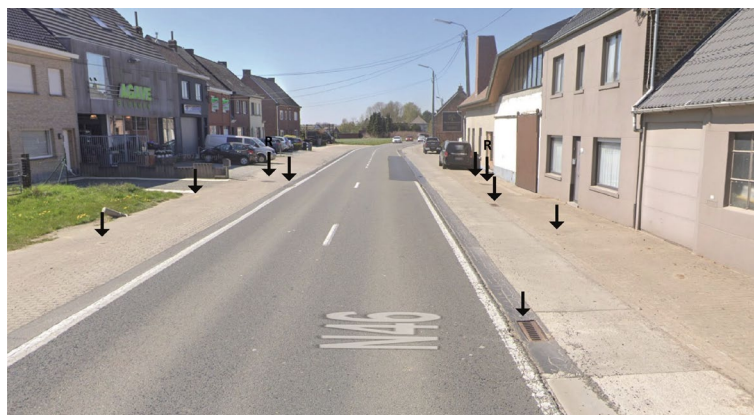
Foto 1 De Provinciebaan (N46) tussen de Slachthuisstraat en de Opstalstraat met aanduiding van bestaande nutsleidingen en riolering (R).
