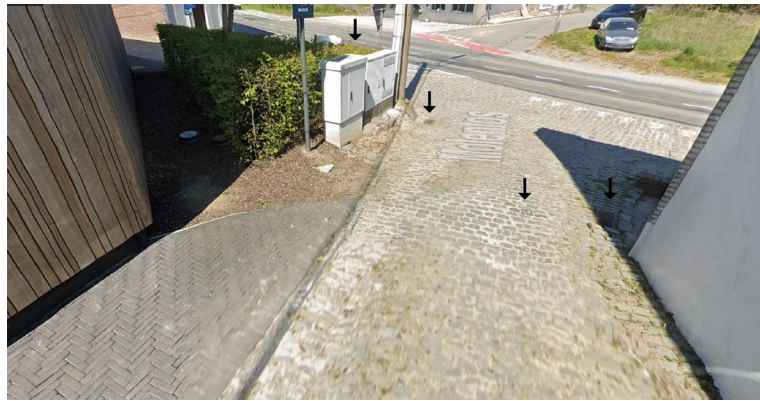
Foto 3 Molenlos met aanduiding van bestaande nutsleidingen en riolering. Zicht naar de N46.
