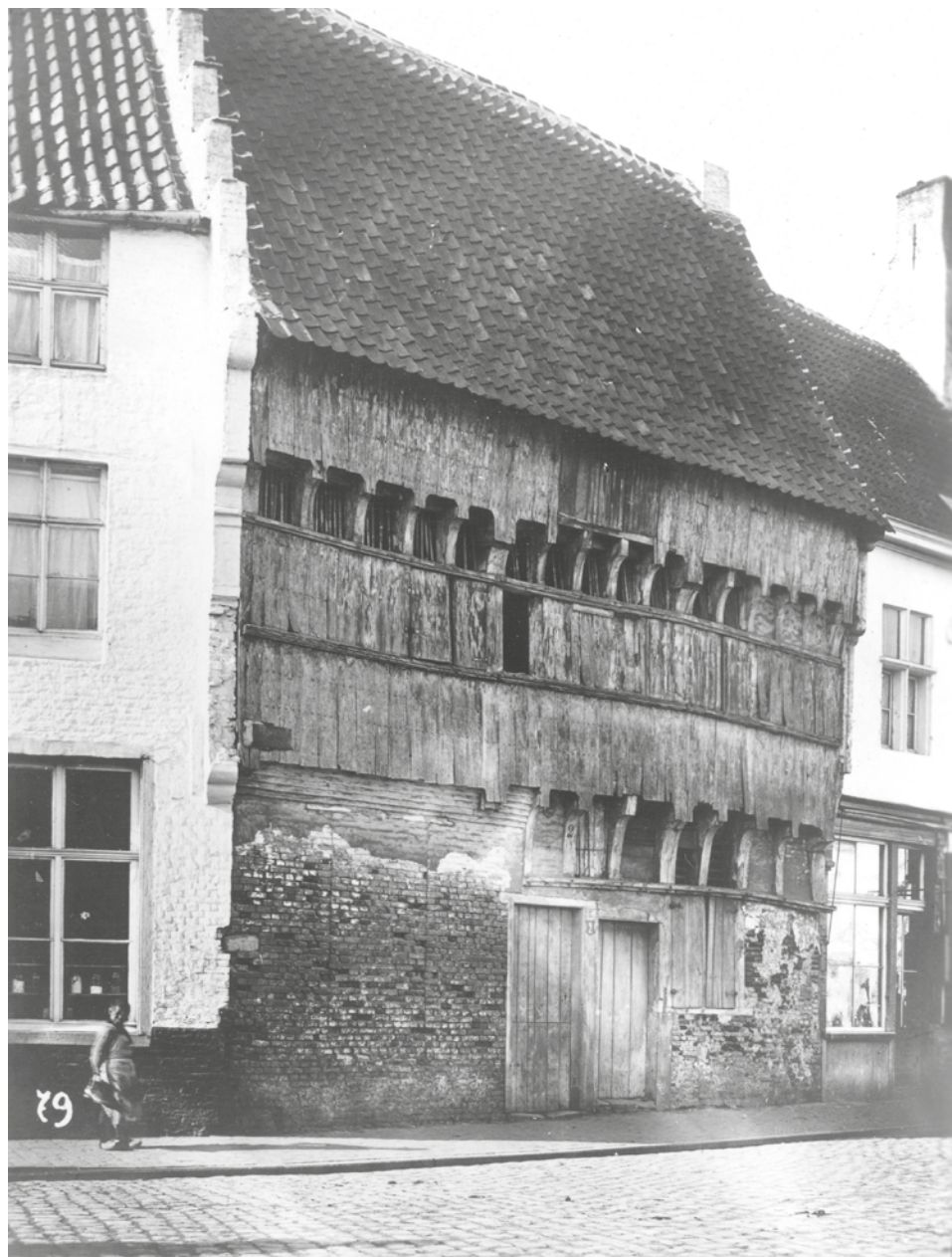
Het laatste gebouw met een houten voorgevel te Aalst 'Den Anckere', gesloopt in 1892 (fotograaf onbekend, ©KIK-IRPA, Brussel).
