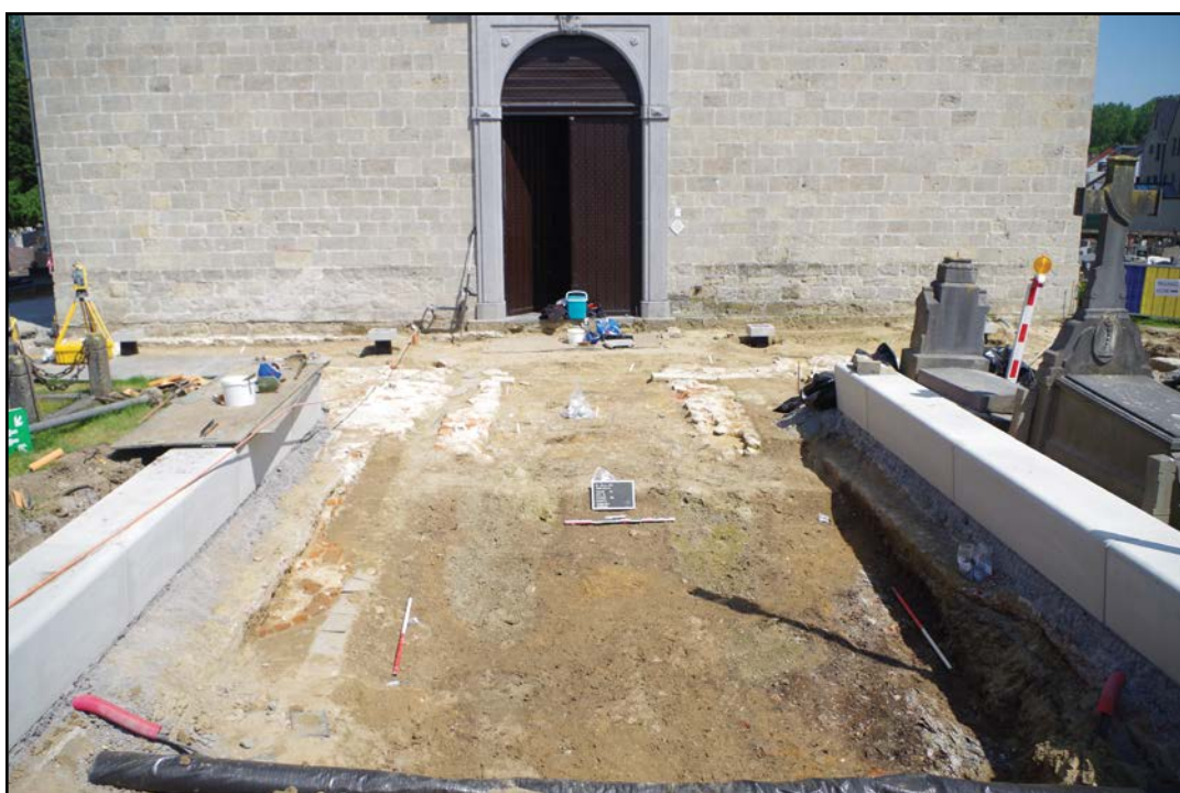
Fig. 59. Zone IV ter hoogte van het toegangspad tot de kerk.
