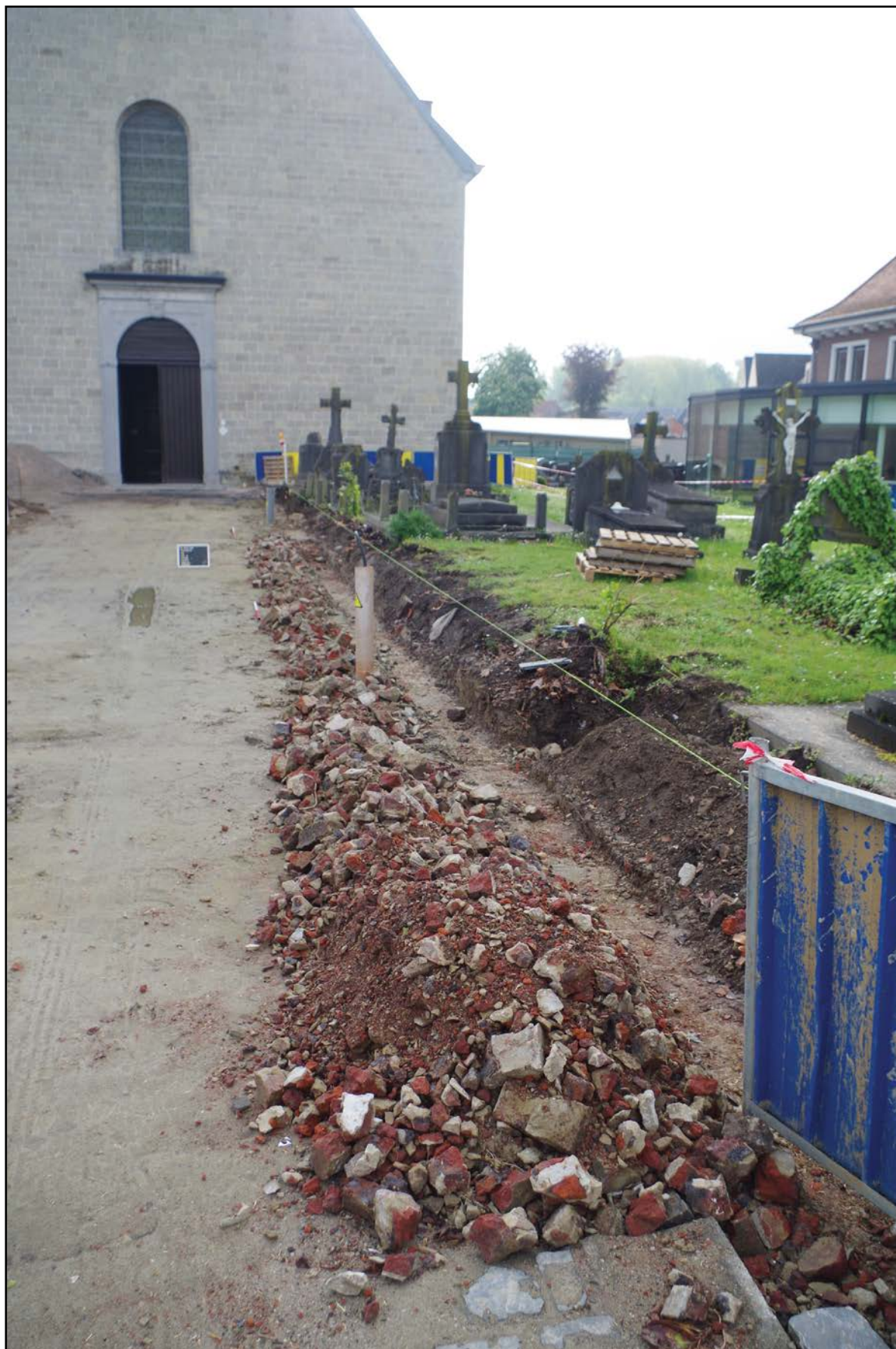
Fig. 22. Afbraak van de kerkhofmuur ter hoogte van de toegangsweg tot de kerk vanuit de Markt.
