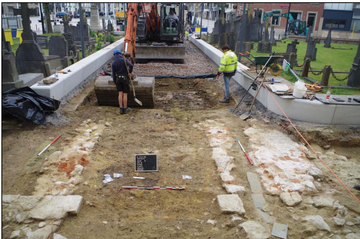
Fig. 15. Begeleiden van afgraving met bandenkraan ter hoogte van toegangsweg tot het kerk vanuit de Markt.
