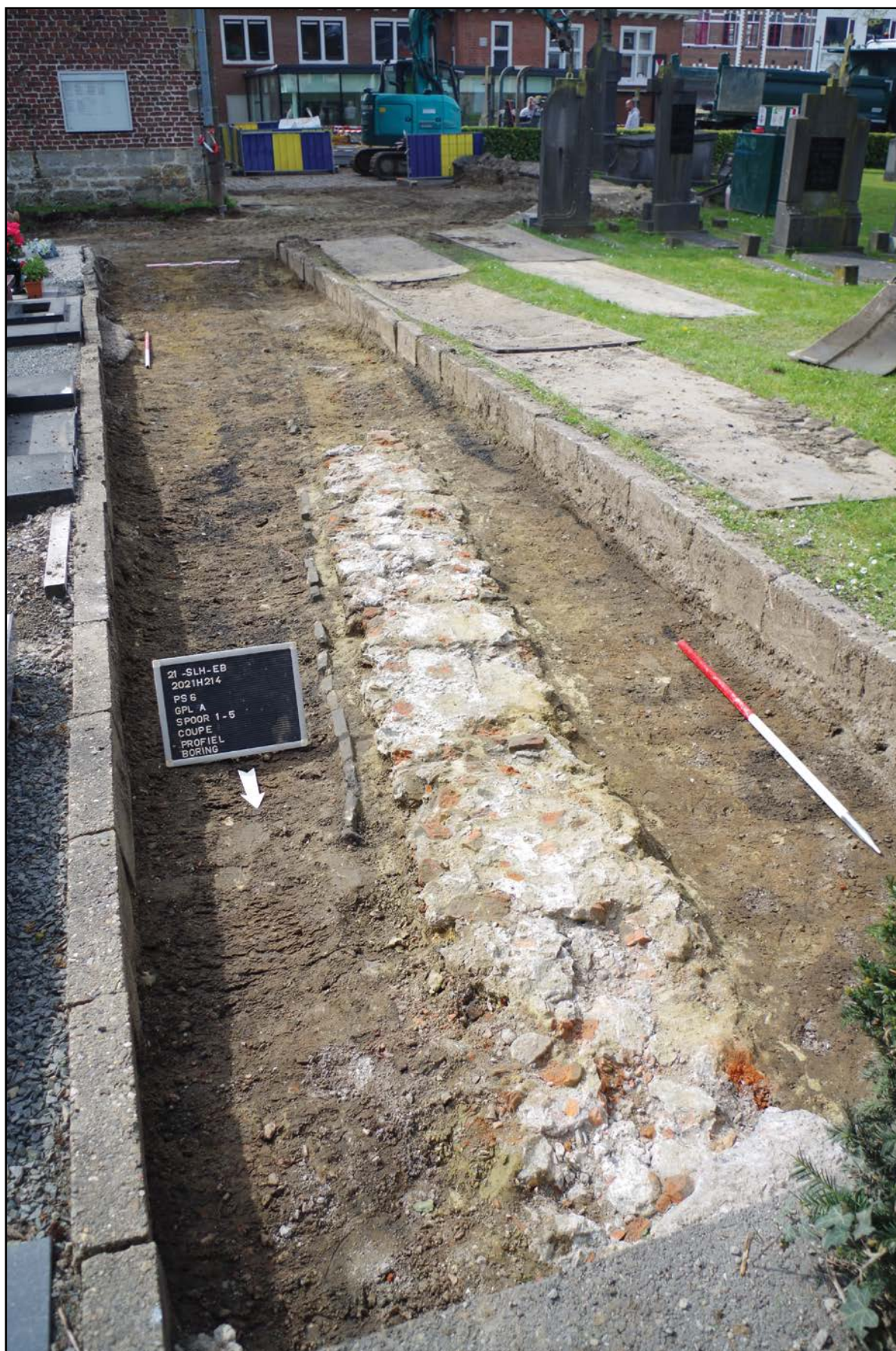
Fig. 19. Heraanleg van het pad naar de pastorie.
