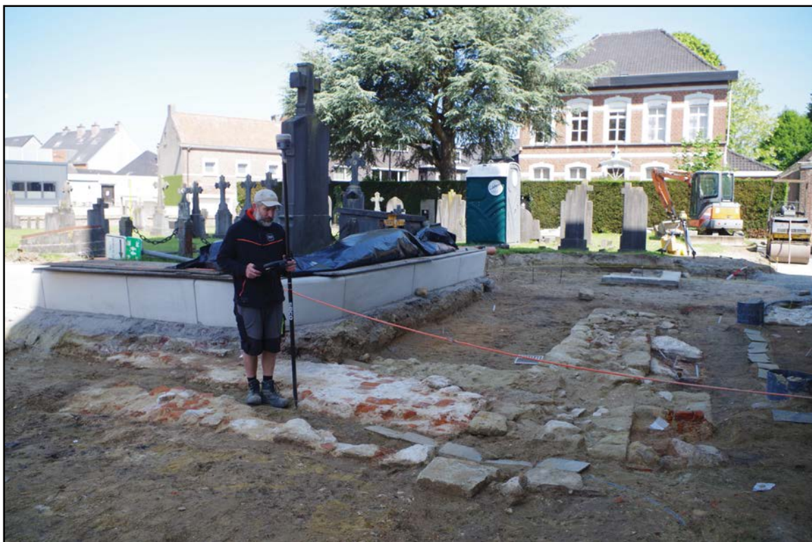
Fig. 17. Digitaal inmeten met RTS.
