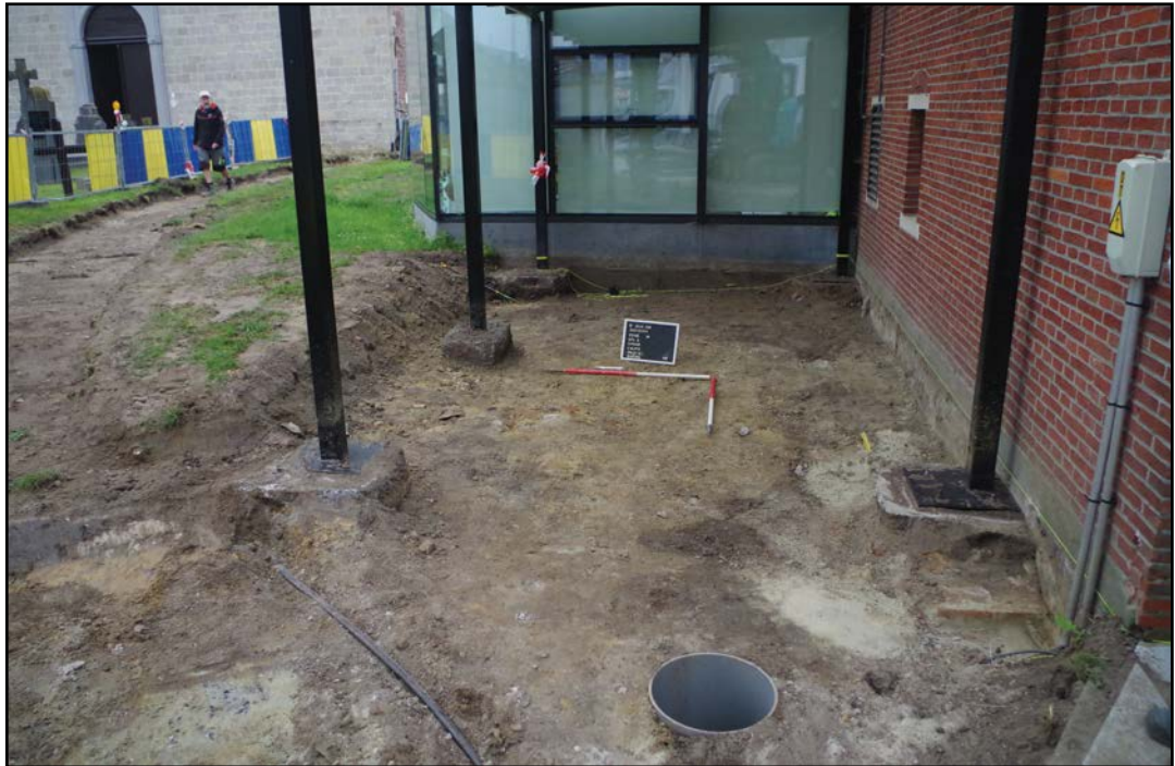
Fig. 80. Zicht op de afgraving ten noorden van het gemeentehuis.
