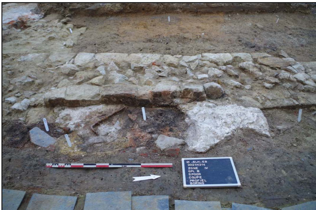
Fig. 86. Detail van de binnenzijde van de voormalige westelijke muur van de kerk.
