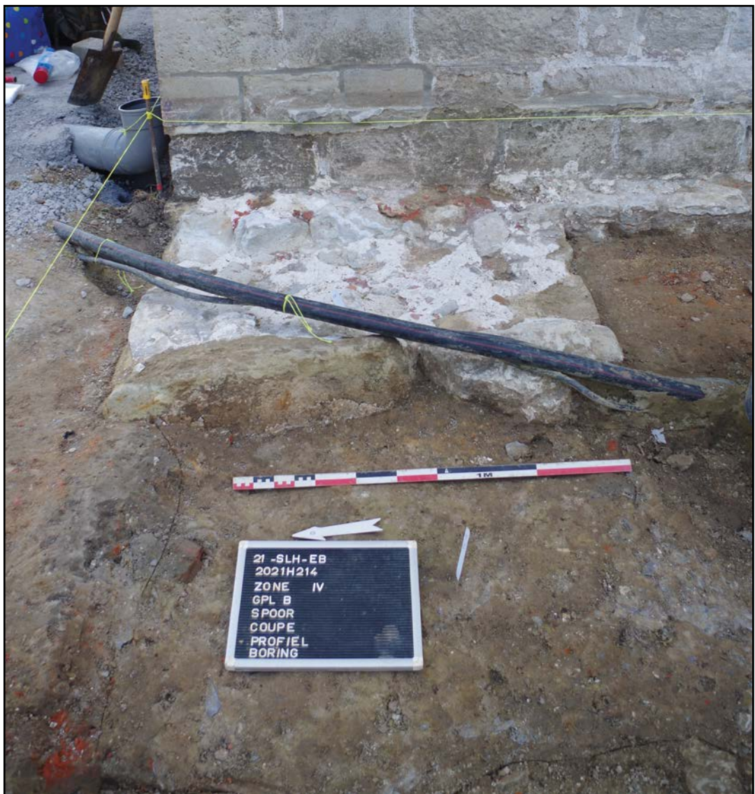
Fig. 91. Zicht op het verstek van de fundering van de huidige westelijke muur van de kerk.
