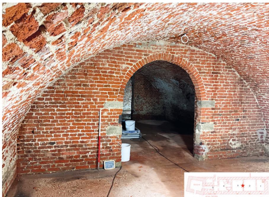
Zicht op kelder 3 met een bakstenen tongewelf en de doorgang naar kelder 2 in de vorm van een rondboog - afbeelding 18
