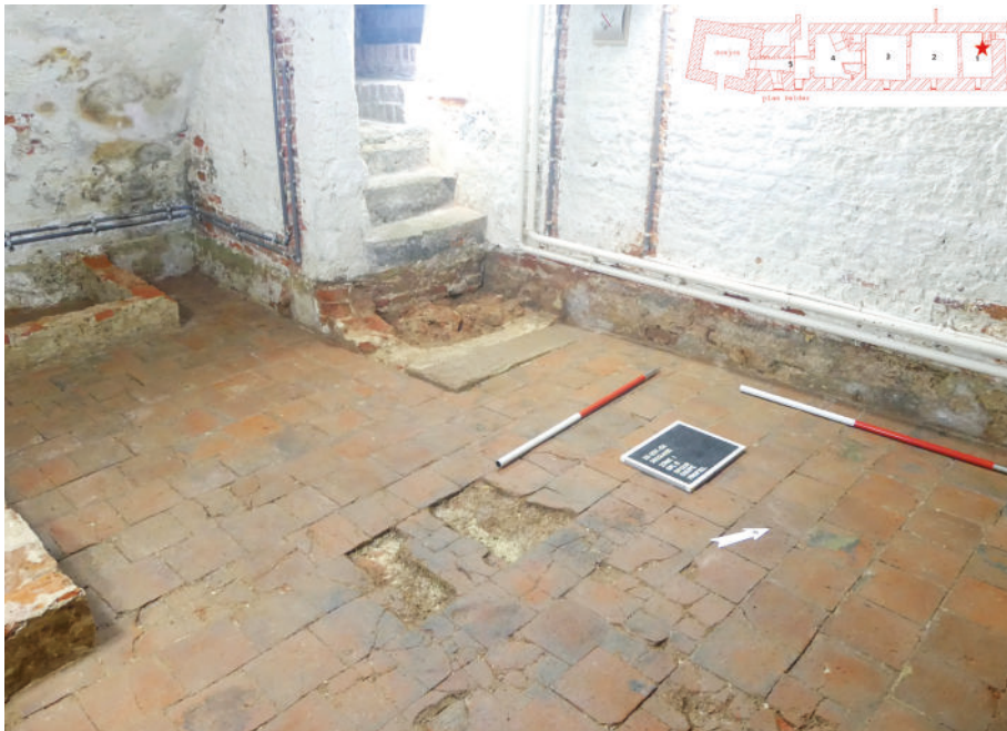
Een goed bewaard vloerniveau van plavuizen (vierkante tegels) in kelder 1 en een bijhorende oudere fase van de toegangstrap - afbeelding 15
