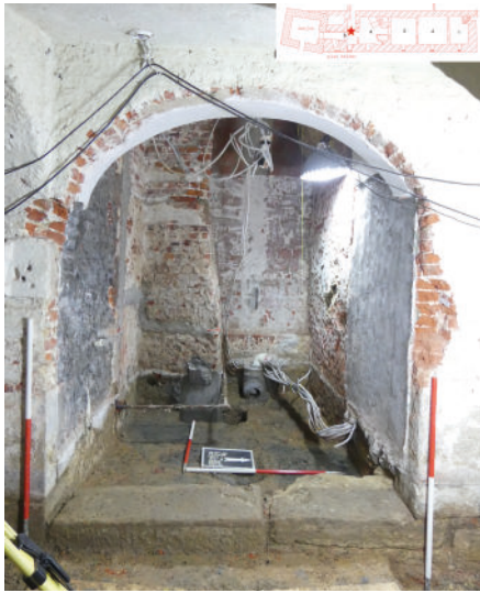
Zicht op de trap in kelder 5 die nagenoeg volledig uitgebroken is en verborgen zat in de sanitaire ruimte. De onderste trede is bewaard gebleven in de vorm van enkele grote blokken natuursteen - afbeelding 20
