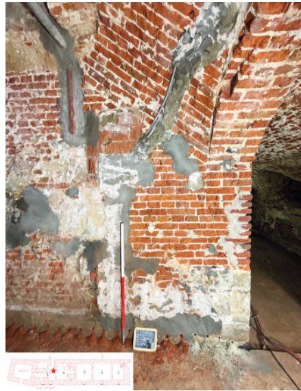
Zicht op de trap in kelder 5, na het verwijderen van een deel van de bepleistering is het omhoog lopende gewelf van het trapgat duidelijk te zien - afbeelding 21
