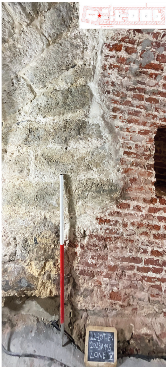
Aansluiting van de kasteelkelders (baksteen) op de deels weggebroken traptoren (natuursteen) van de donjon - afbeelding 19
