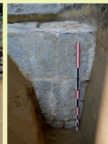
19. Buitenzijde van de fundering van de stadstoren.
