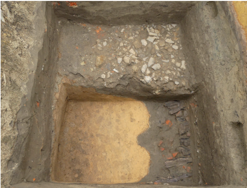
Zicht op enkele voorgangers van de huidige hoofdrijweg. Bovenaan een kasseiweg uit de 17de-18de eeuw en onderaan een ouder wegniveau op houten liggers en bakstenen, aangelegd in de opgevlude “holle weg”.
