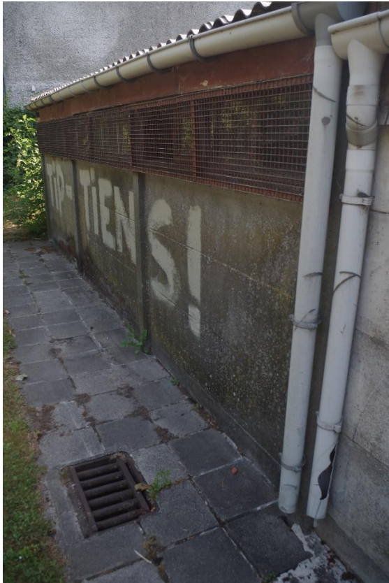
Foto 6 Bestaande infrastructuur met waterafvoer langsheen het sportveld
