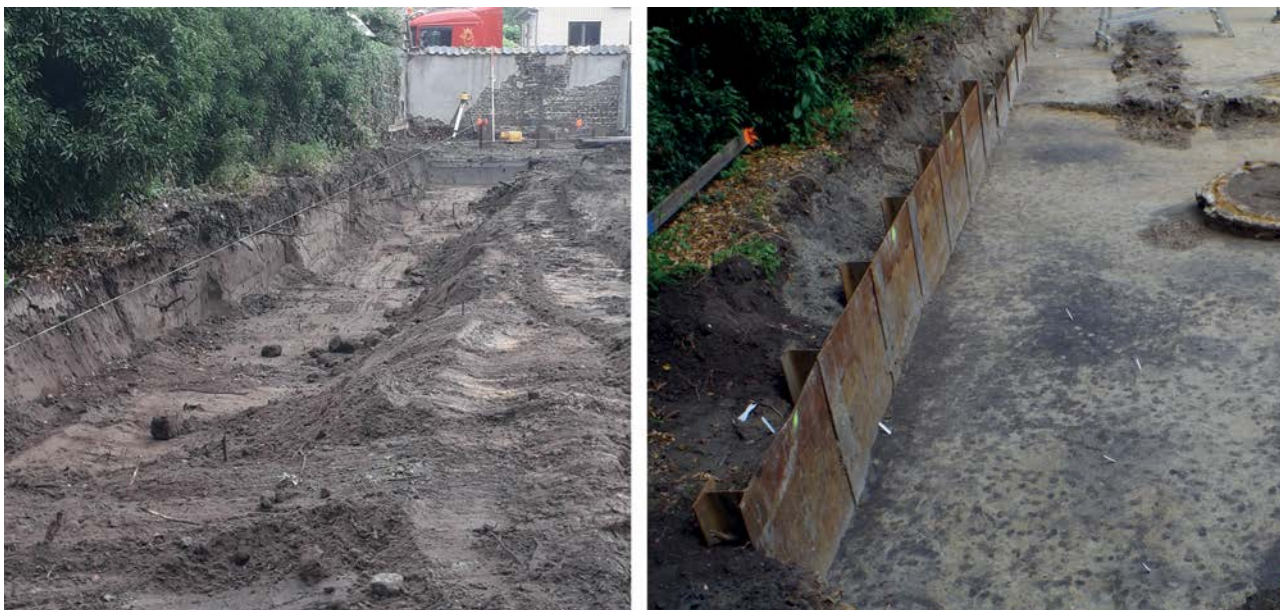
Afb. 1. Foto's van de aanleg sleuf voor de berlinerwand tijdens de aanleg (links) en de berlinerwand na plaatsing (rechts).
