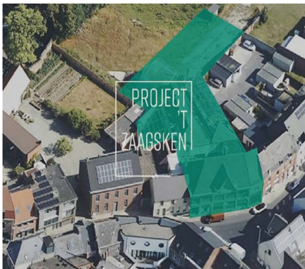
Afb. 29. Luchtbeeld van project 't Zaagsken.
