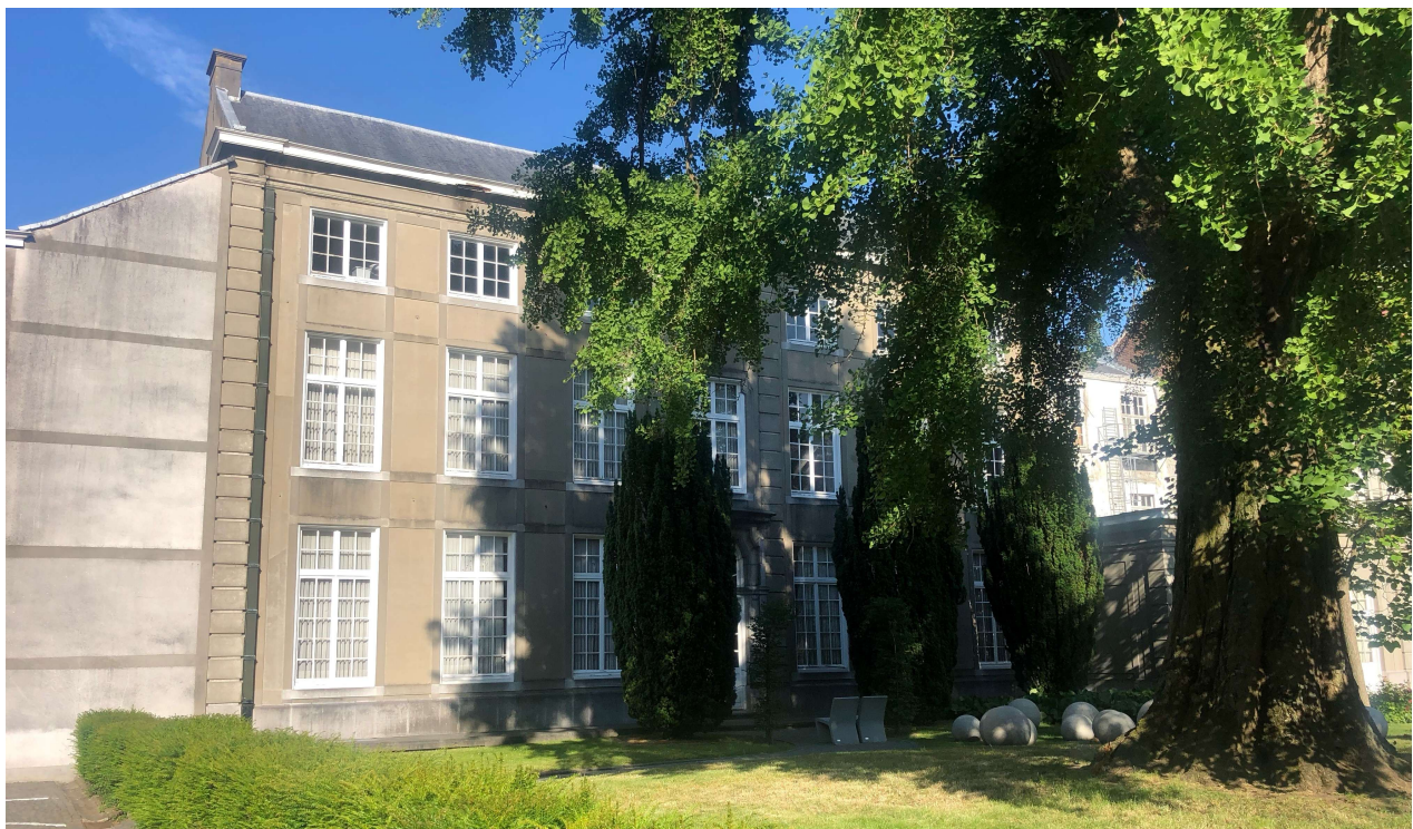
Foto 6: Zicht op de achterzijde van het Hotel Van Langenhove
