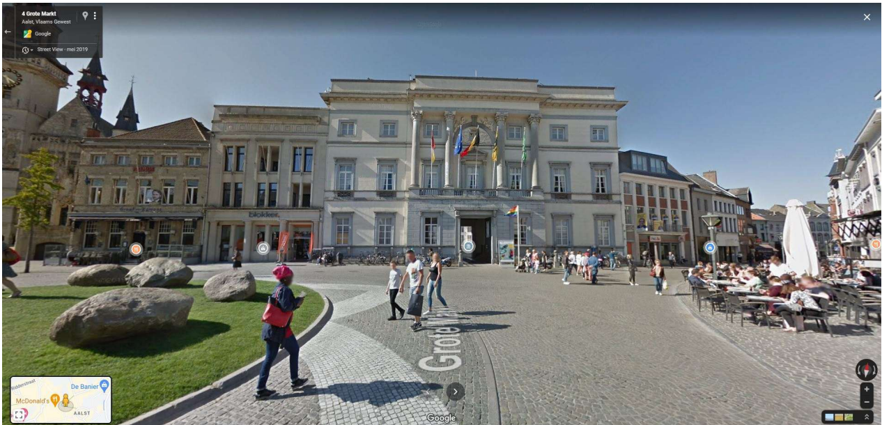
Foto 1: Zicht op het voormalige Stadhuis vanop de Grote Markt (bron: Google Streetview 2019)
