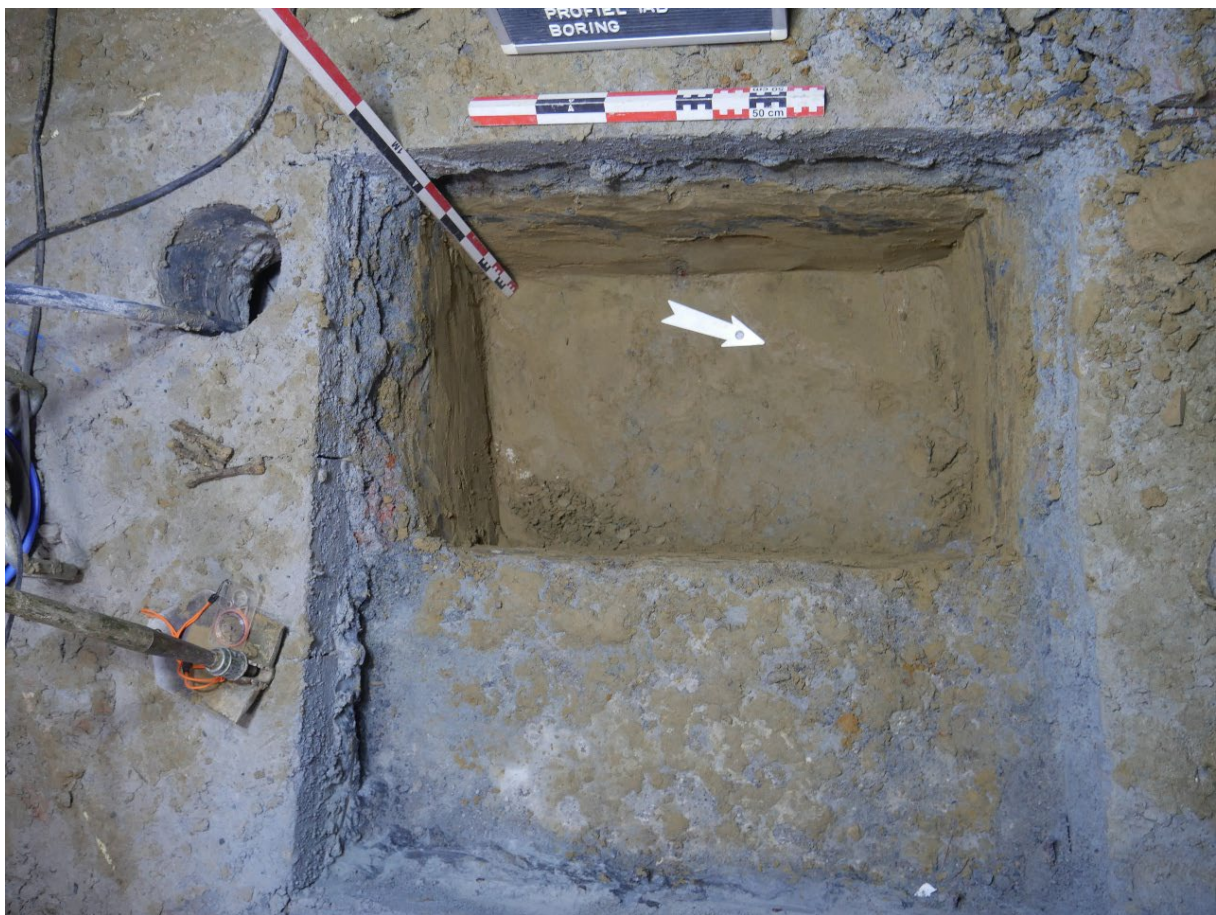
Foto 7: Zicht op de betonnen ringbalk in Zone I.
