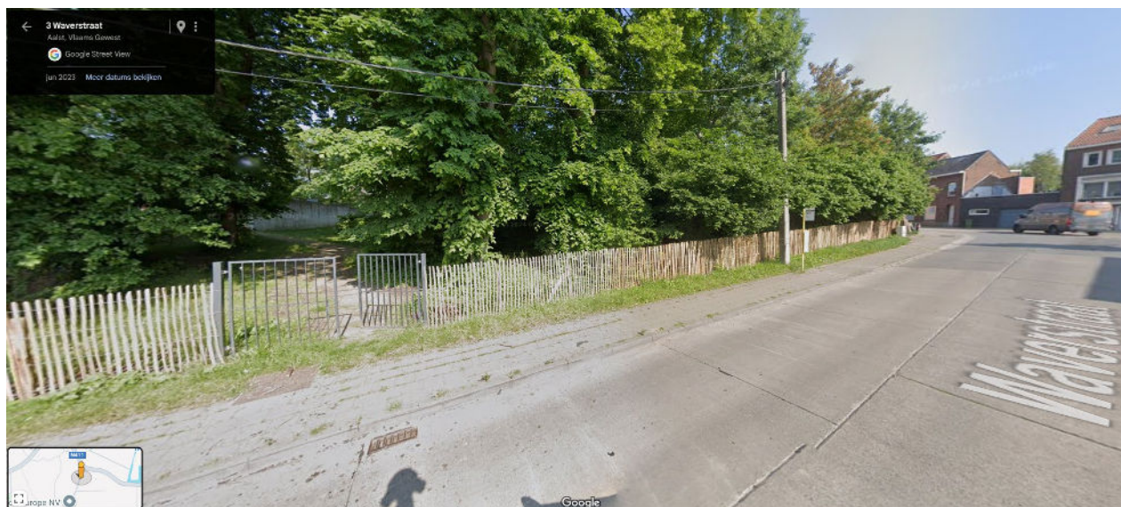
Foto 1. Zicht op het noordelijke uiteinde van de Waverstraat, de deksels zijn zichtbaar in het voetpad.
