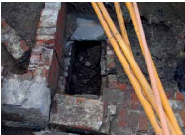
Afbeelding 25: Zicht op rioleringskanaal II-A--YZ-16.
