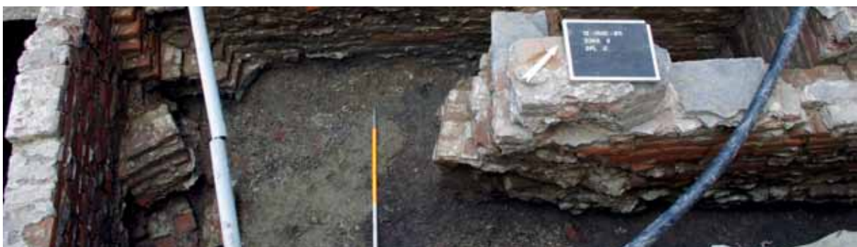
Afbeelding 21: Zicht op onafgestreken mortelsporen aan de buitenzijde van muur II-A-22.
