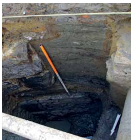
Afbeelding 49: Verstek aan de buitenzijde van de westmuur van de oostelijke toren.
