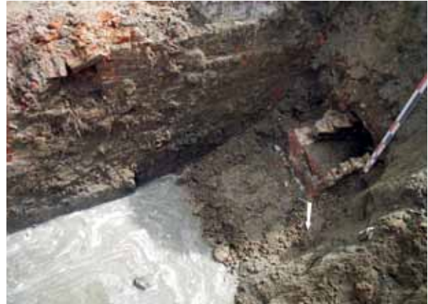
Afbeelding 24: Zicht op riolering II-A-50.
