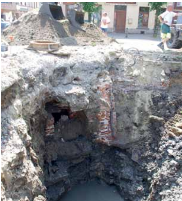
Afbeelding 12: Riool in baksteen en Doornikse kalksteen in zone I.
