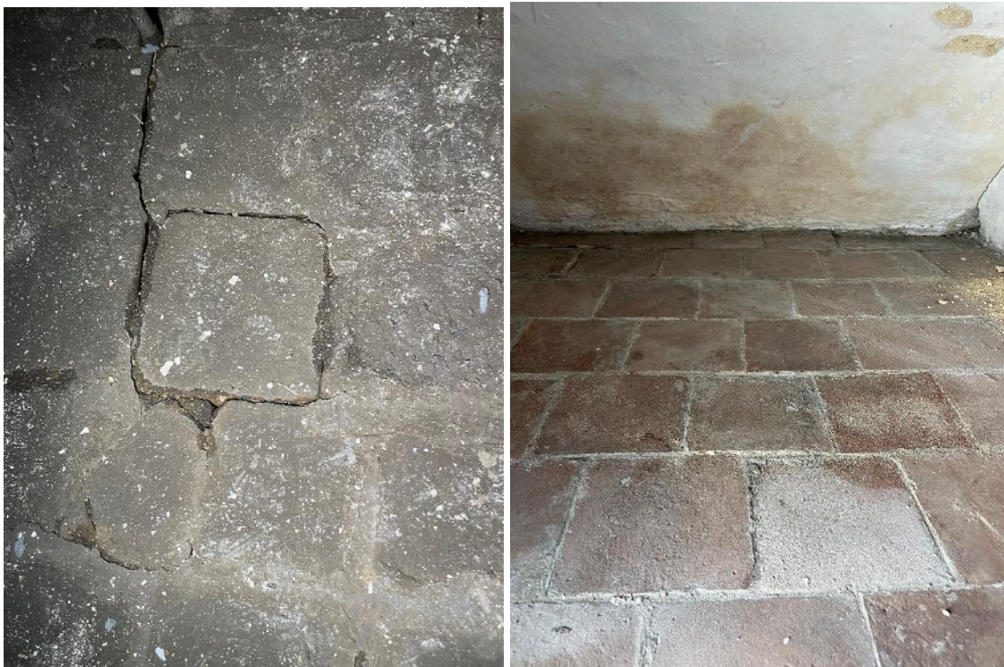
Foto 5: Arduinen tegels en plavuizen in kelder huisnummer 5 Peperstraat.
