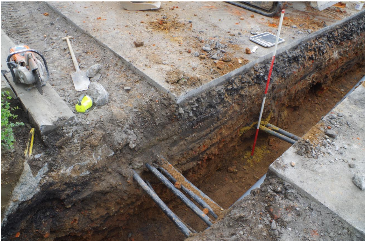
Foto 42: Opvolging van een van de nutsleidingen op de parking achter het stadhuis in 2019. Op ongeveer 1,25 m onder de parking werd een van de muren van de 17 de -eeuwse pastorie aangetroffen. Erboven zijn dikke puin- en ophogingspakketten aanwezig.
