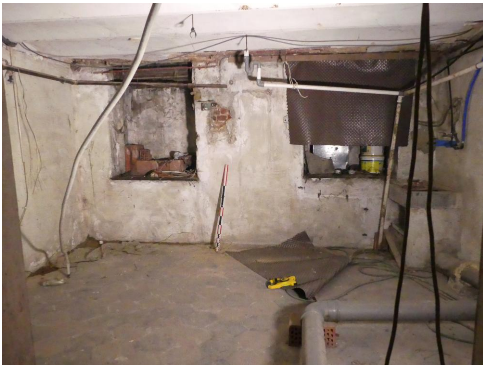
Foto 3: Zuidelijke deel van de kelder (huisnummer 3, Peperstraat).
