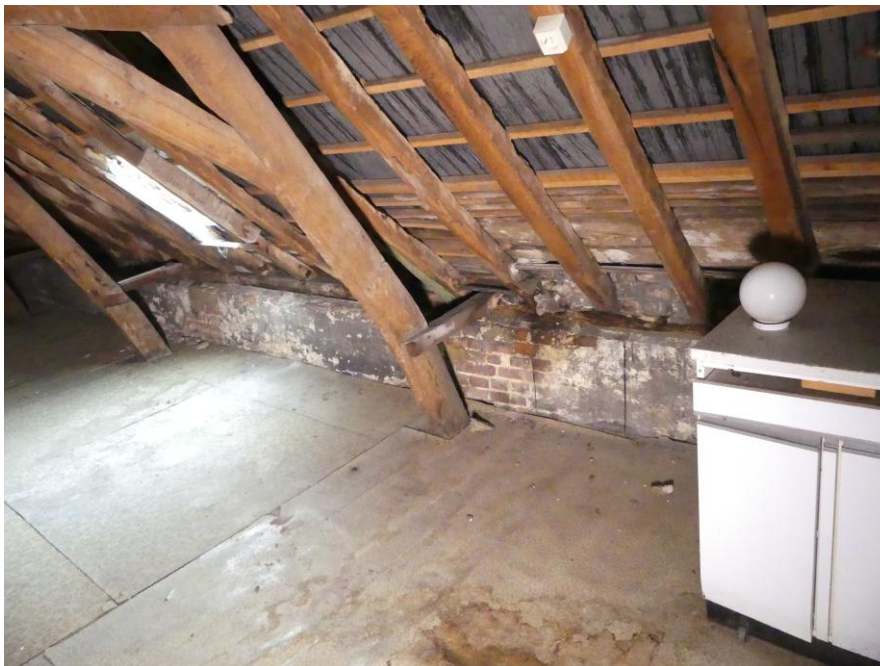
Foto 9: Kappoten met blokkelen verankerd aan muurplaat in haaks ingeplante achterbouw huisnummer 5 Peperstraat.
