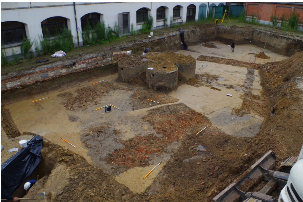
Foto 13: Zicht vanuit zuidoostelijke hoek op grondplan D van fase 1
