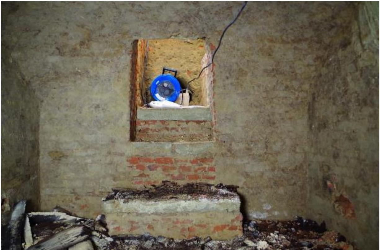
foto 34: zicht vanuit noordoostelijke hoek op de zuidwestelijke toegang tot de grafkelder; de afdaling naar deze kelder geschiedde door middel van drie hoge traptreden.
