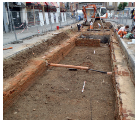
Zicht op de zuidelijke pandgang
