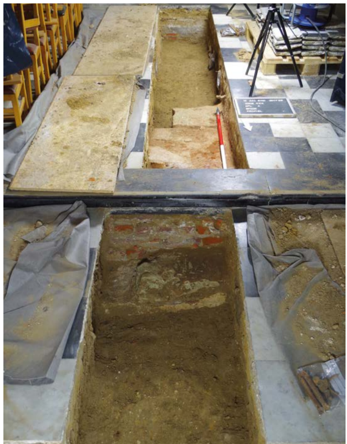
Figuur 143. Zicht op natuurstenen fundament XXX-2 en bakstenen bovenbouw XXX-3.
