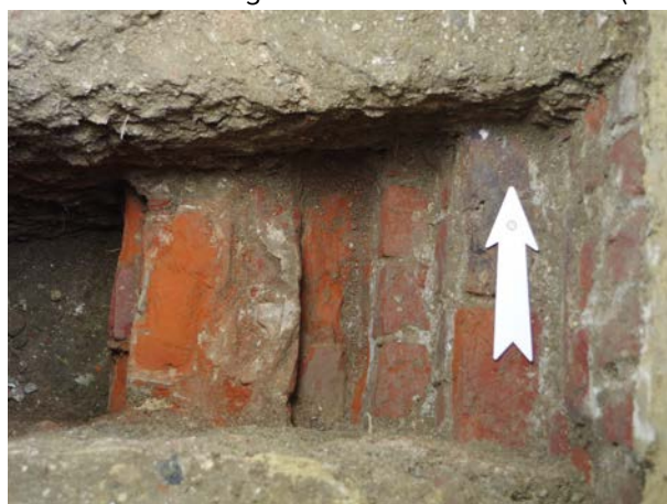
Figuur 150. Oude fundering binnen de bloemenkelder: aan noordelijke zijde is de vertrapte fundering van de huidige buitenmuur onmiddellijk tegen de oude fundering geplaatst.
