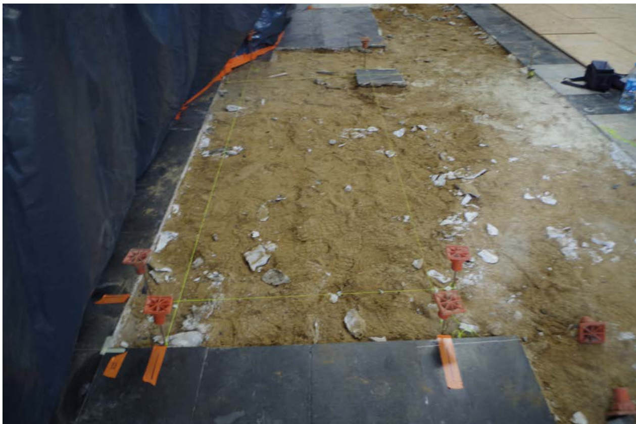
Figuur 7. Zicht op werkput XIV nadat de werkmannen van Monument Vandekerckhove de bestaande tegelvloer hebben uitgebroken.
