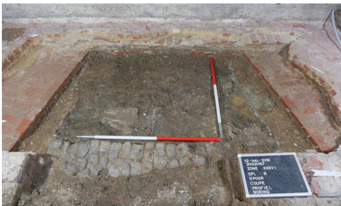
Afbeelding 12: Restant van de kasseivloer tussen muren XXXVI-7 en XXXVI-8 en de opmaaklaag van deze kasseien ten westen ervan.
