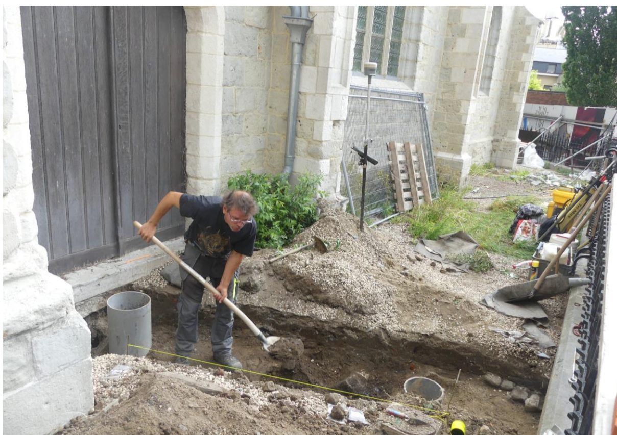
Afbeelding 2: Zicht op het uitgraven van werkput XXXVIII.
