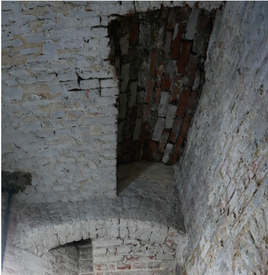
Afbeelding 24: Plafond kelderannex met dichtgemetselde opening.
