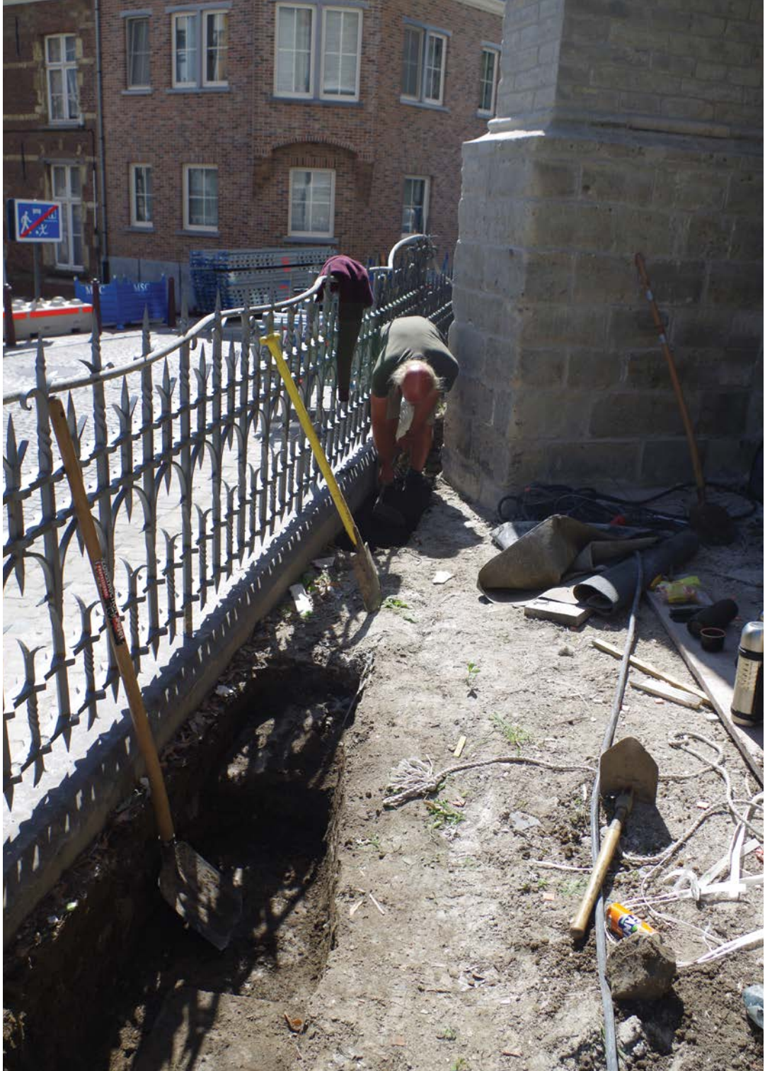
Fig. 5. Zicht op het uitgraven van werkput XXXIII.
