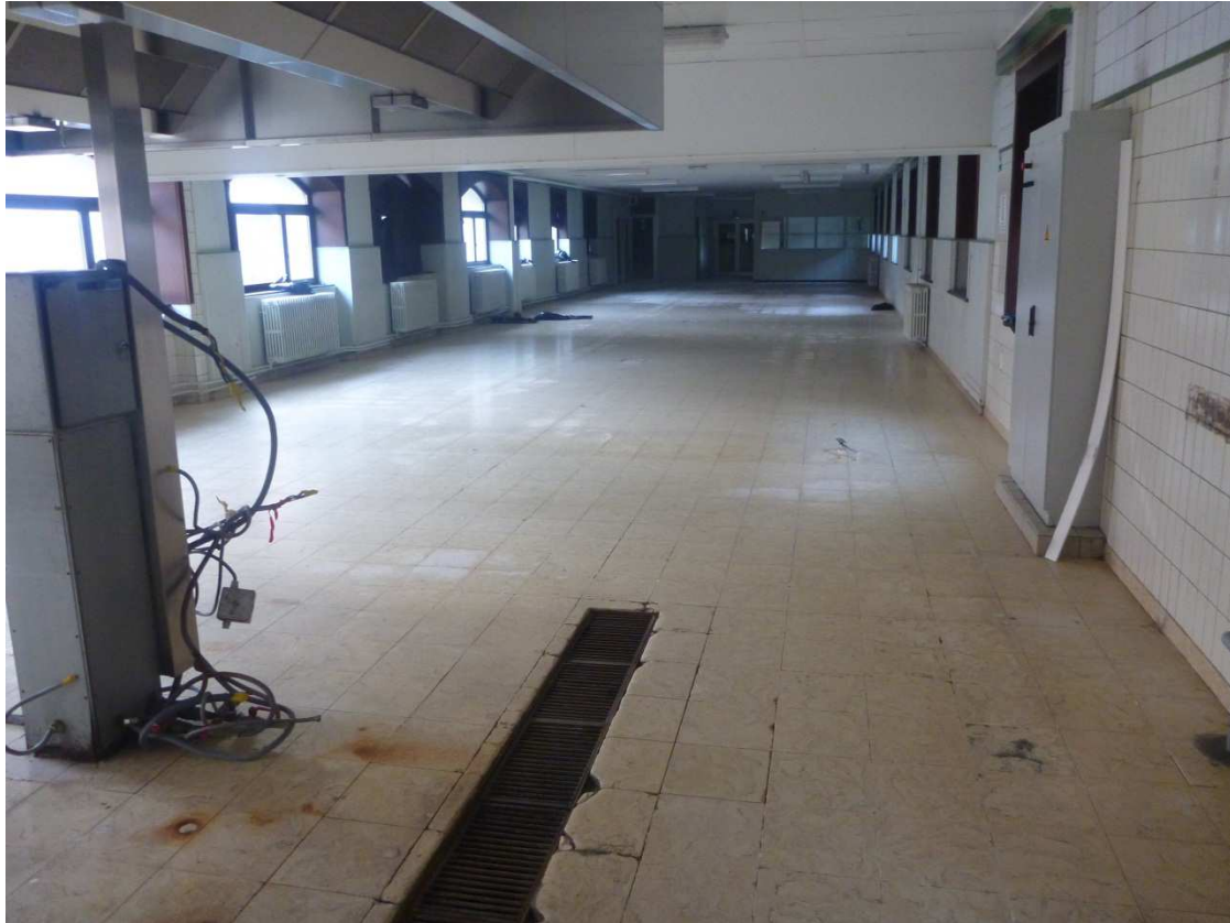
Figuur 23: foto van een ruimte met (afvoer)rooster
