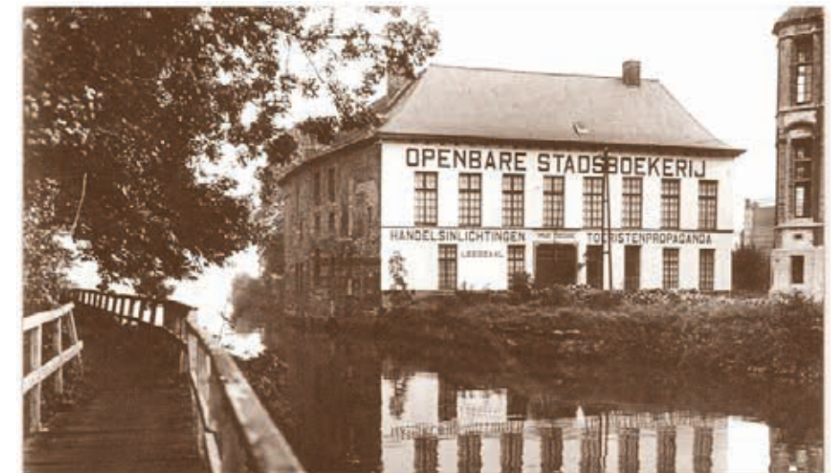
Figuur 3: Deze foto toont de voorgevel van het kasteel ten tijde van de functie als bibliotheek. Opvallend is dat de ronde uitsprong op de zuidoostelijke hoek, zoals deze zichtbaar is op het Bijzonder Plan n°4, hier niet te zien is.
