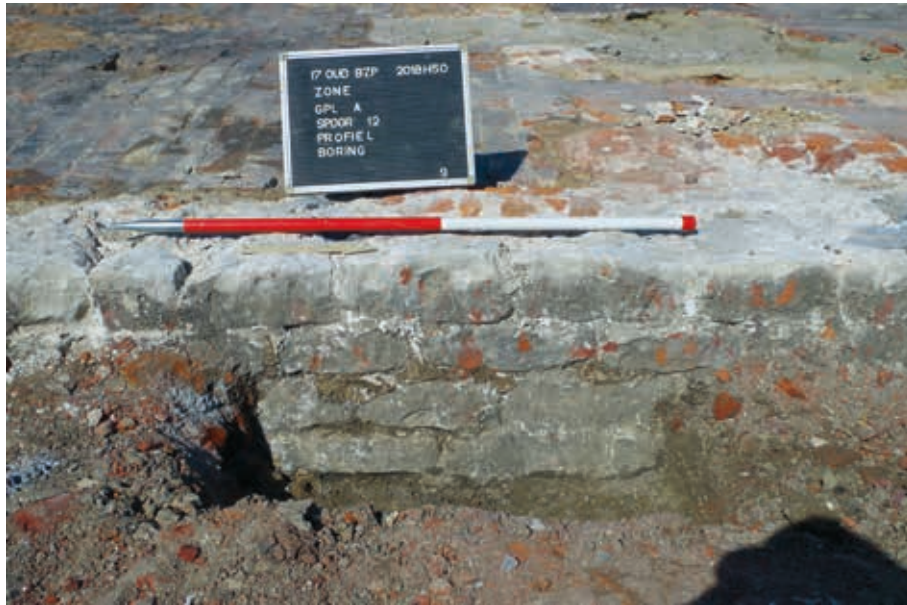
Figuur 10. Detail van het parement en de gevelpleister.
