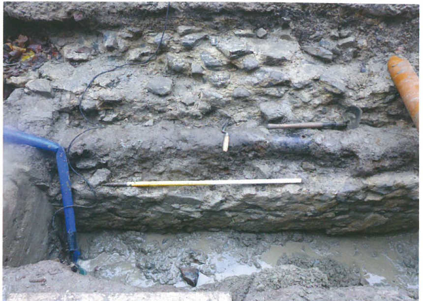
Fig. 17: Zicht op de niet afgestreeken mortelresten in de fundering van de Brusselpoort.
