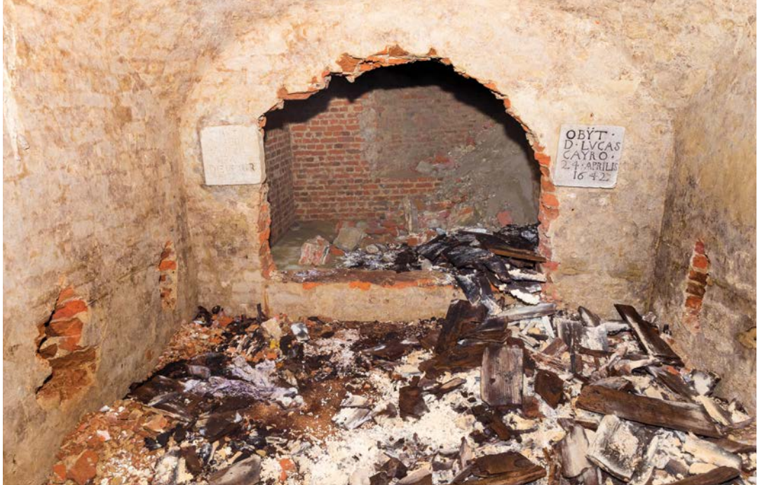
Fig. 51. Zicht vanuit de zuidwestelijke toegang op de grafkelder. De twee originele inscripties zijn zichtbaar, maar ook de sporen van de 19de eeuwse plundering (grote opening in de dwarsmuur, verspreiding van puin, hout en schimmel). De gaten in de beide zijmuren herinneren vermoedelijk aan de plaatsen waar een of ander houten staketsel of constructie in de muur bevestigd was, teneinde de overledenen op te baren (© Dirk Wollaert).
