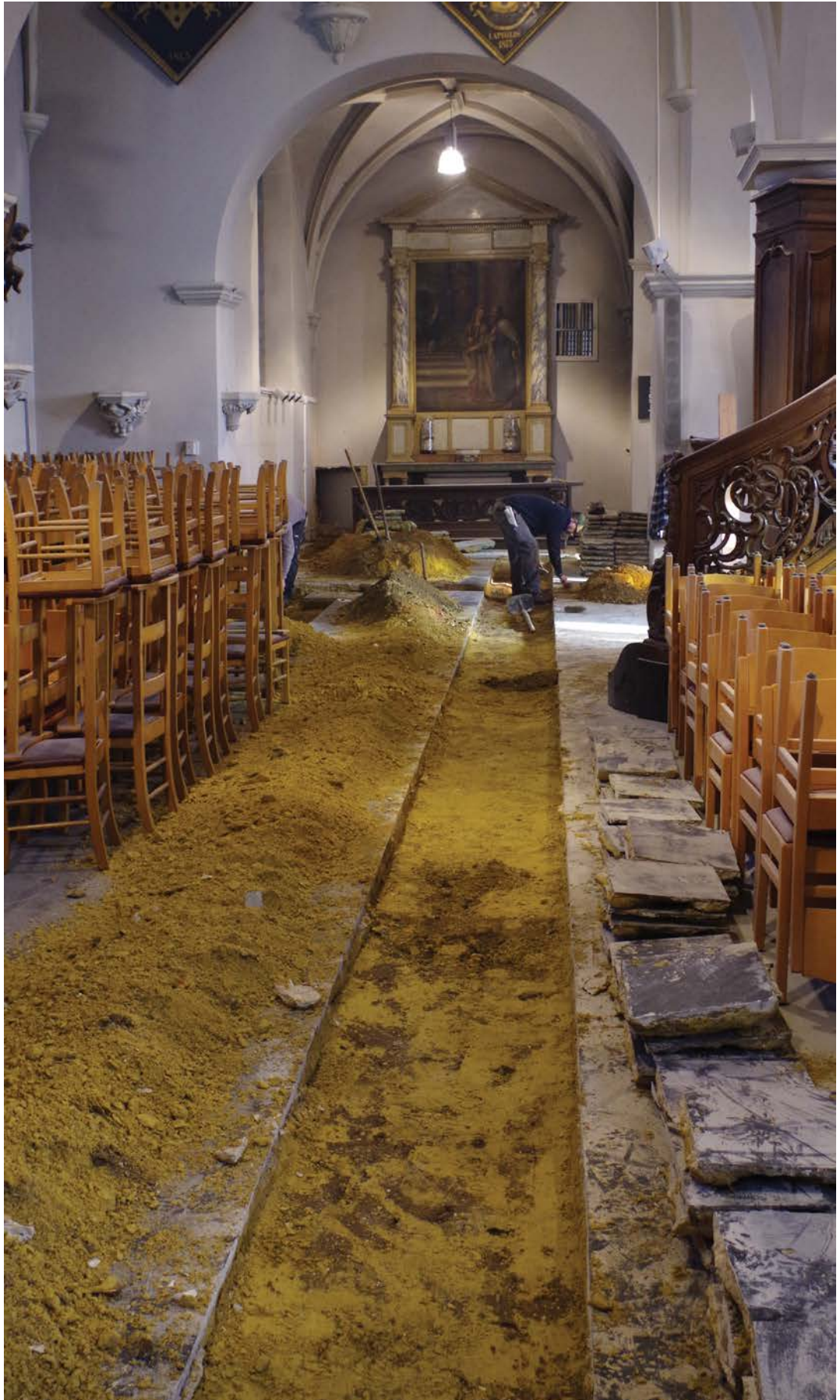
Fig. 6. Zicht op de leidingssleuf ter hoogte van de noordwestelijke zijbeuk, nadat de bestaande tegelvloer werd uitgebroken en het verwijderen van het onderliggende zandbed van de vloer werd gestart.
