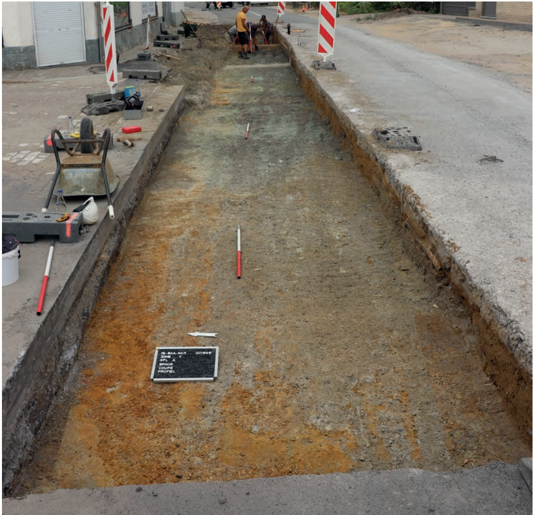
Fig. 140. Wegtracé in het noorden.
