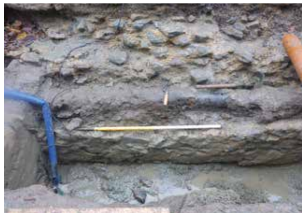
Afb. 22: Mortelresten tussen de stenen zijn duidelijk zichtbaar.
