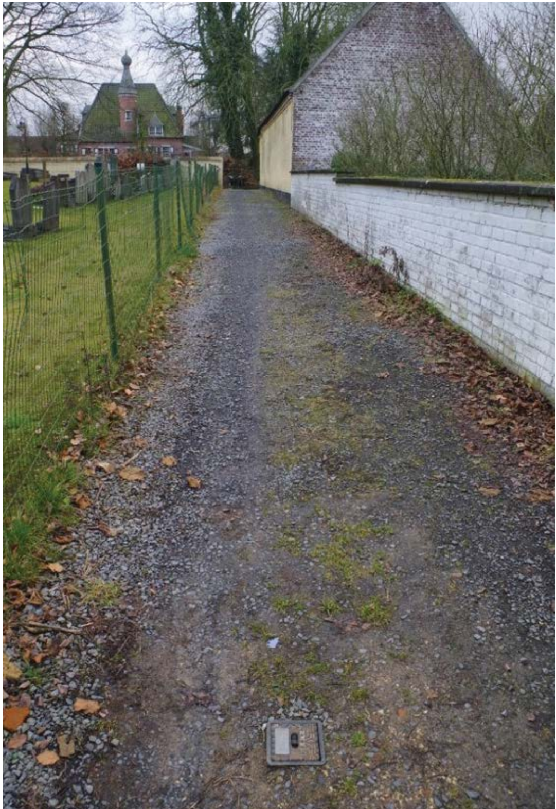
Afb. 1. Zicht op de locatie van de geplande persleiding (zicht naar het zuiden) met links het kerkhof. Op de voorgrond is een deksel van de bestaande nutsleiding te zien (terreinbezoek op 06-02-2017).
