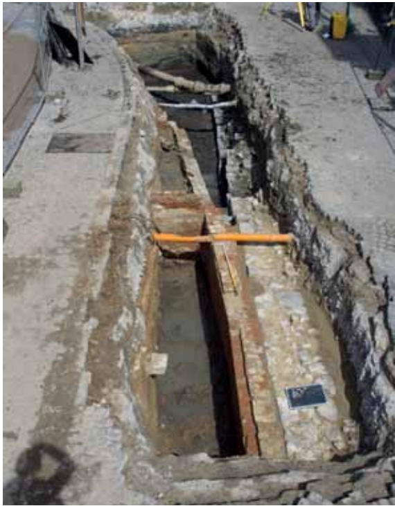
Afbeelding 28: Context II-16: de fundering van de brug op de rechteroever van de Schelde.
