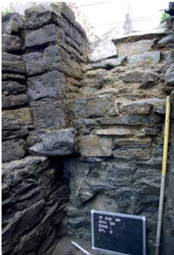
Afbeelding 22: De brug en de toren zijn in verband gebouwd.
