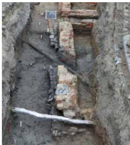
Afbeelding 52: Zicht op riool II-21.
