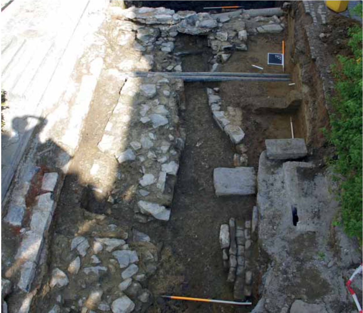
Afbeelding 49: Zicht op riool I-8.
