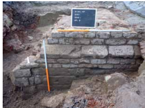
Afbeelding 34: Afzaat in natuursteen van bakstenen aanbouw.
