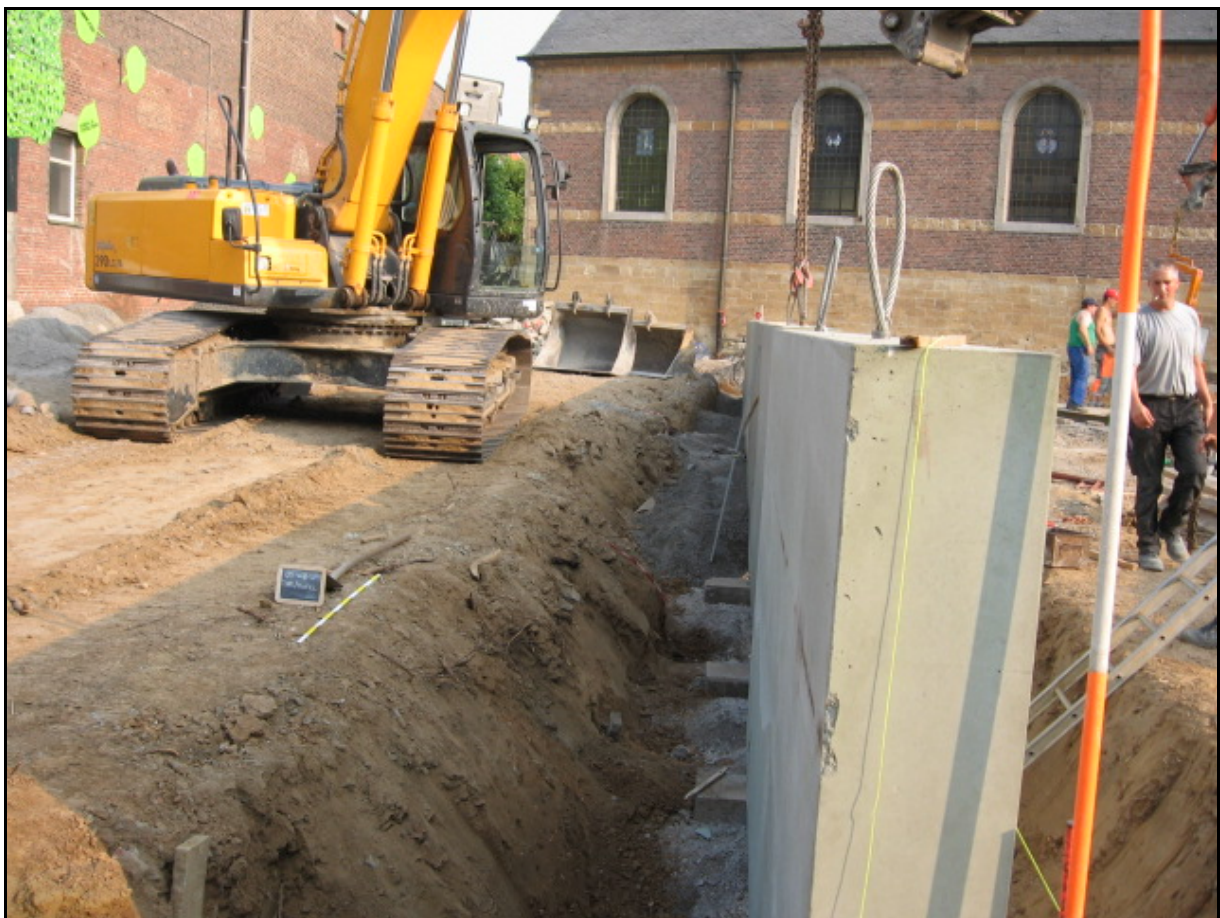
Afbeelding 1: De plaatsing van de betonnen muur ten zuiden van de kerk.
