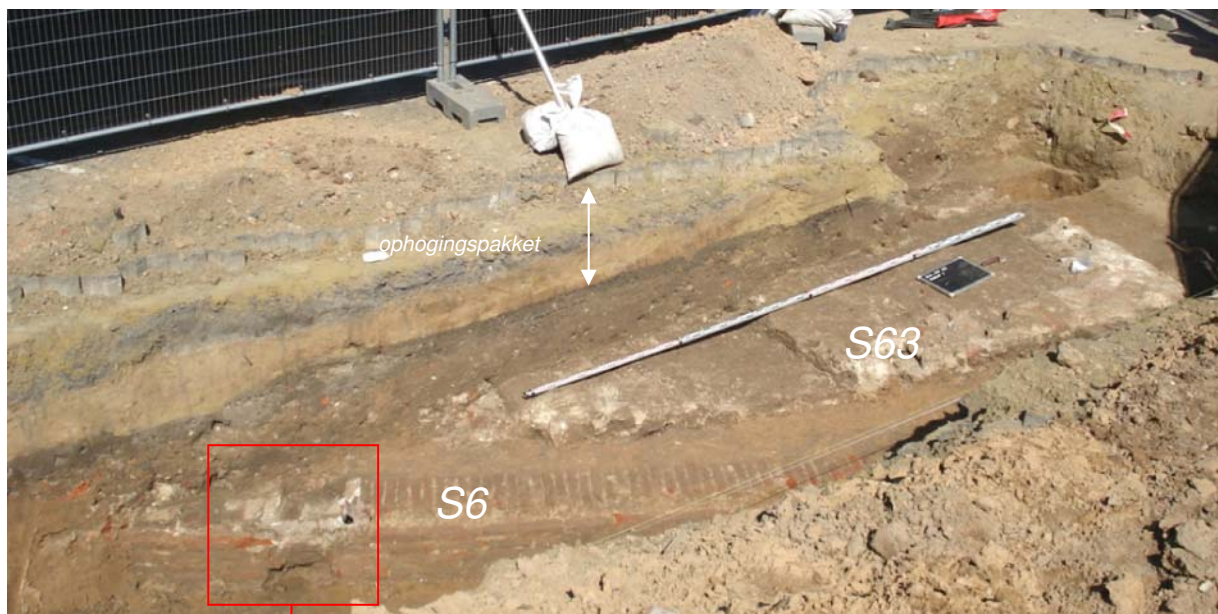
Foto 3: Sleuf 1, noordzijde, westprofiel. Zicht op de hoek van het schepenhuisje (S63) en de recentere riolering (S6). In de rode kader de versterking van de goot.
