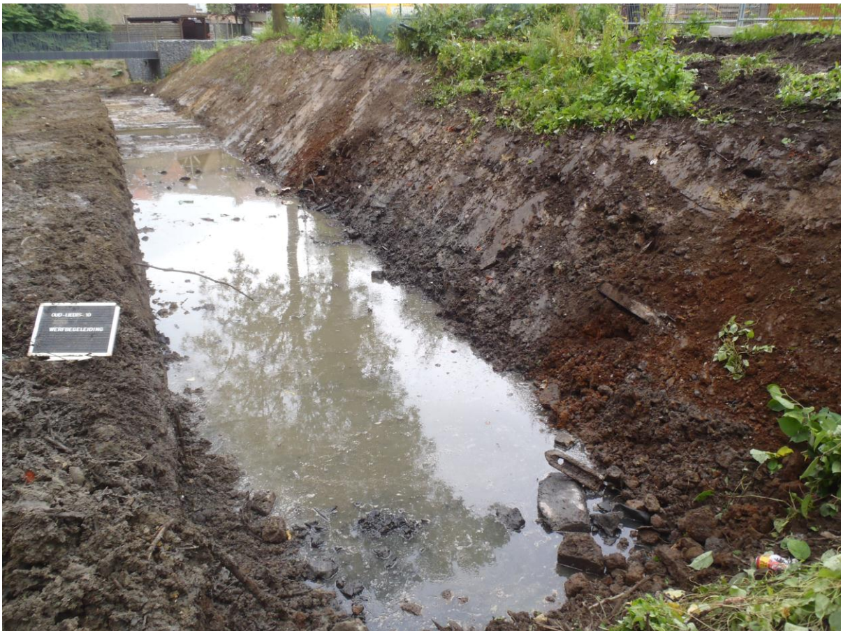
Figuur 23: Zicht op de berm en sleuf in de gracht, fase 2.
