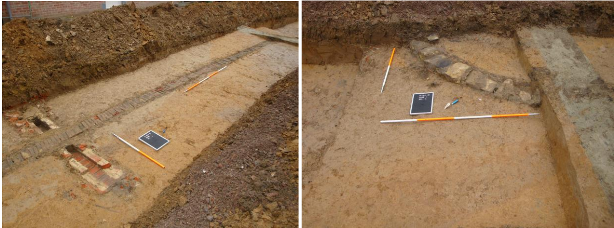
Figuur 7, 8: Bakstenen constructie van de riool met daar loodrecht op een oudere constructie (zone I, spoor 6); afbuiging in de oostelijke sleufwand.
