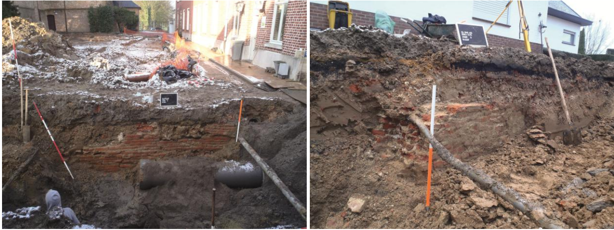
Figuur 64 en 65: Muur II-A-161/162.
