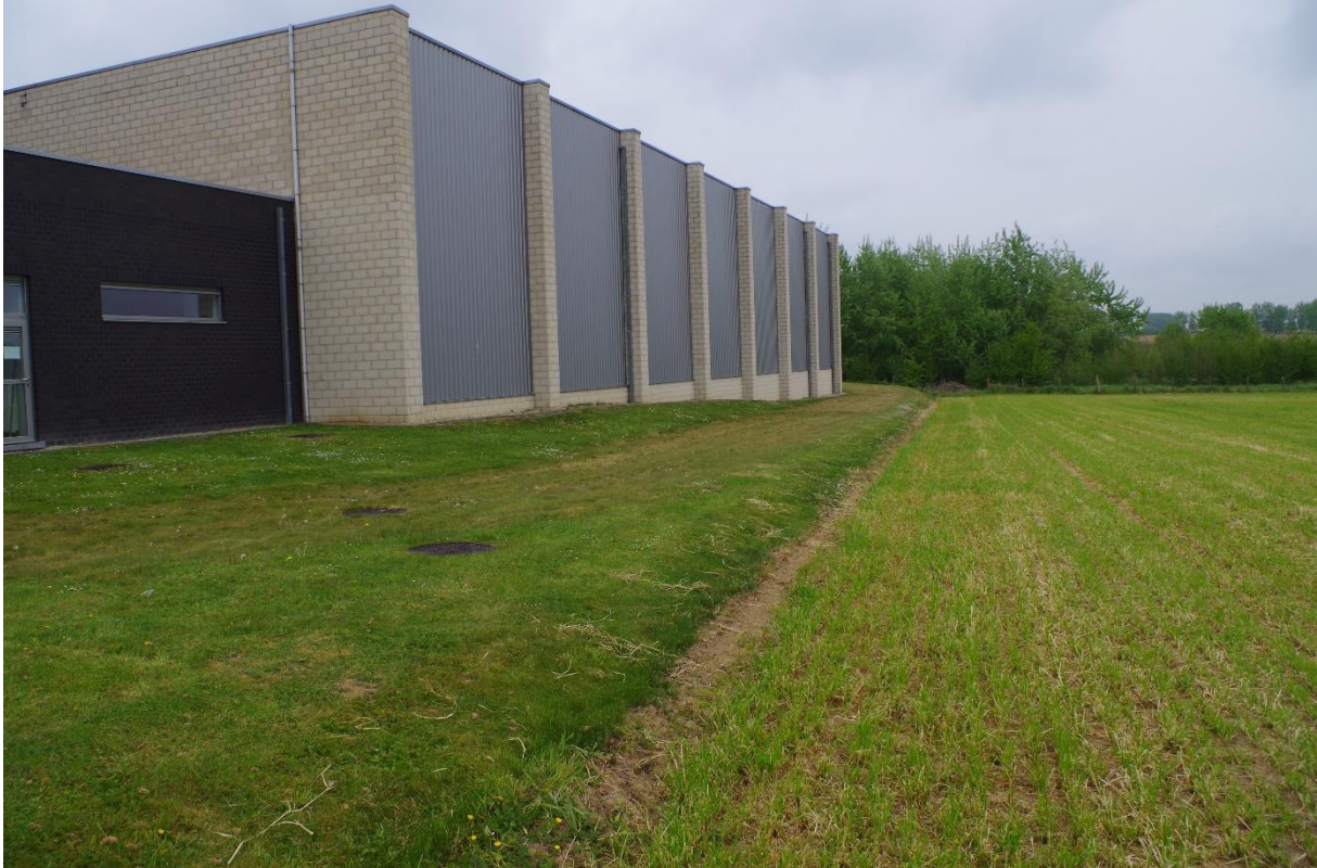
Foto 2. Foto van de bestaande situatie (2 mei 2017). Zicht richting oosten op de ophoging waarop de sporthal gesitueerd is. Putdeksels geven de locatie aan van een RWA- en DWA-riolering in deze zone.
