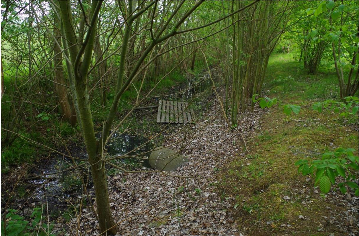
Foto 5. Foto van de bestaande situatie (2 mei 2017). Zicht richting zuiden op het bestaande bufferbekken met riolering.
