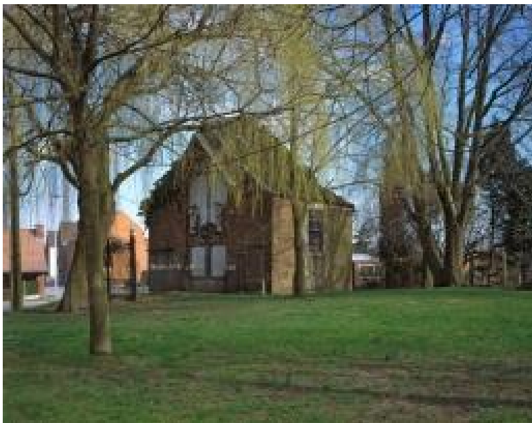
Foto 4. Sacristie van de voormalige parochiekerk van Herdersem die in het midden van de 19 de eeuw werd verplaatst naar de huidige locatie (Vandevorst 01.01.2005, Copyright Vlaamse Gemeenschap).
