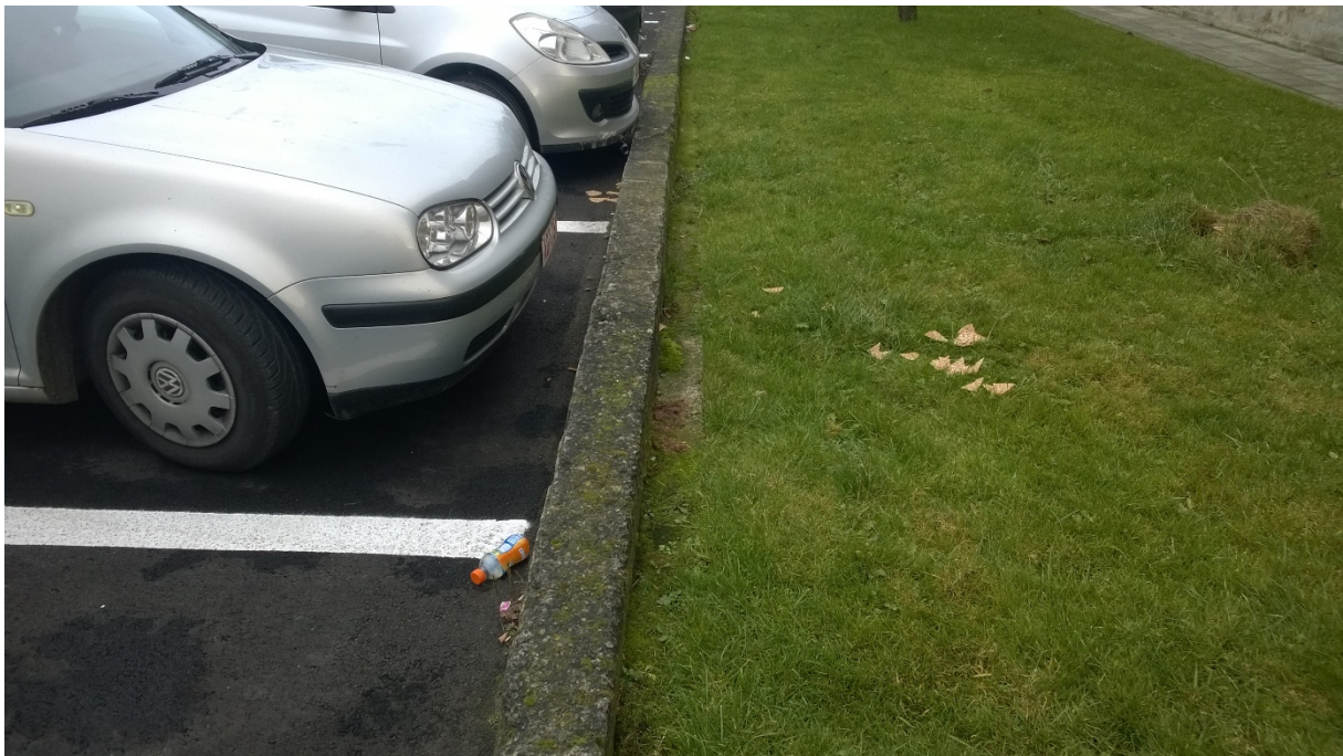
Foto 5. Foto van de grens van de bestaande parking en grasperk aan de noordelijke zijde van de kerk. (terreinbezoek 14-12-2016 © SOLVA).
