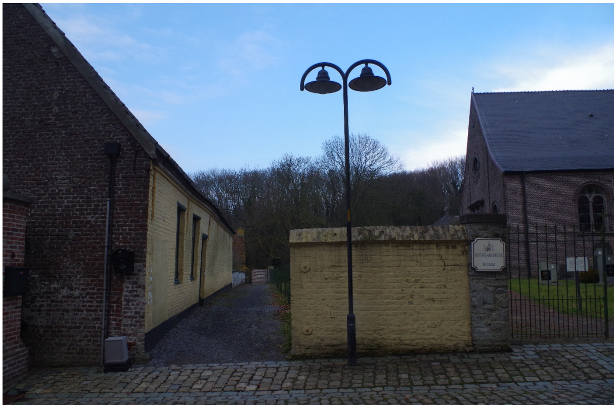
Foto 2. Zicht op de locatie van de geplande persleiding naast de kerk (figuur 6, zone 16) (terreinbezoek op 06-02-2017 foto © SOLVA).
