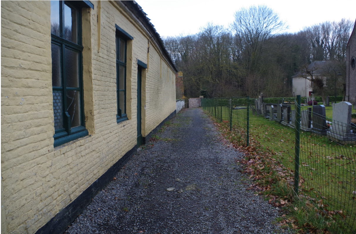
Foto 3. Zicht op de locatie van de geplande persleiding naast de kerk (figuur 6, zone 16) (terreinbezoek op 06-02-2017 foto © SOLVA).
