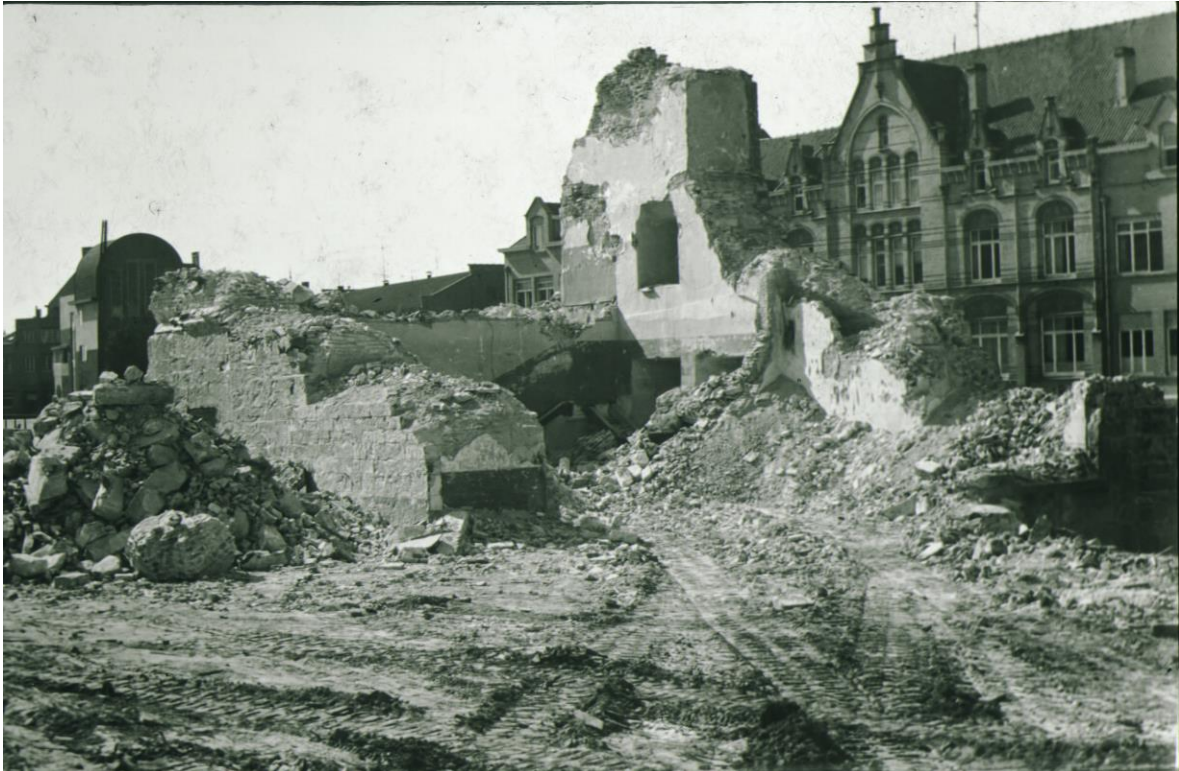
Foto 7. Zicht op het kasteel bij afbraak. Achteraan is het gerechtsgebouw zichtbaar (Foto: Stadsarchief Oudenaarde, 1970_098_027_032).
