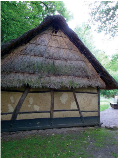
Voorbeeld van een huis dat gebouwd is op liggers (Provinciaal Domein Bokrijk). Deze bouwwijze laat archeologisch gezien geen sporen na in de bodem. ©Arne De Graeve.
