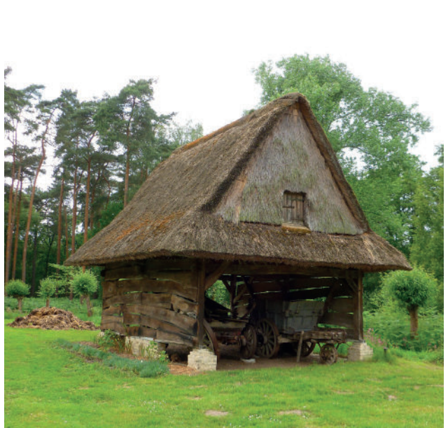
Voorbeeld van een gebouw op poeren (Provinciaal Domein Bokrijk). Ook deze vorm van bouwen heeft slechts een beperkte impact op de bodem. Hierdoor is het zeer moeilijk om zulke gebouwen archeologisch te traceren. ©Arne De Graeve
