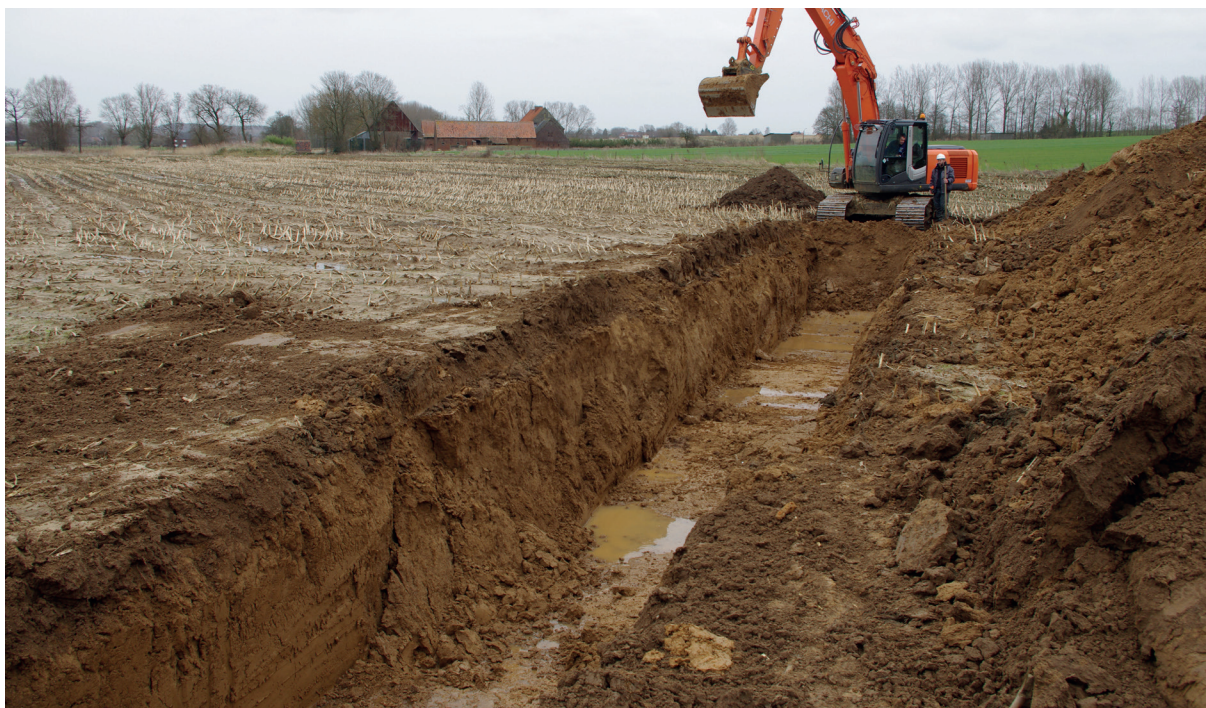
Afbeelding 8: Proefsleuf 60 met ingestorte wanden en trapsgewijze afgraving.
