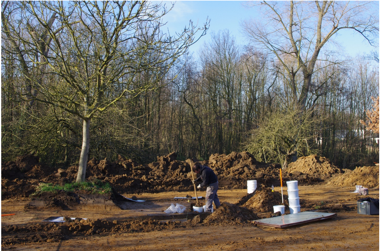
Afbeelding 6: Zicht op het aangelegde kijkvenster.
