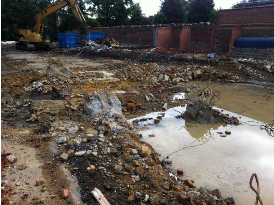
Figuur 3: zicht op de sloopwerken van de bovenbouw (04/07) van het zuidelijke deel van de filmzaal ter hoogte van de te verwachten bakstenen muur
