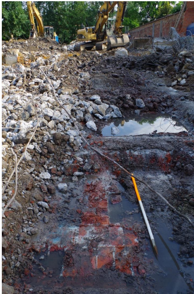
Figuur 4: zicht op de sloopwerken (07/07) met de verwachte bakstenen fundering in een wirwar van beton en ijzer
