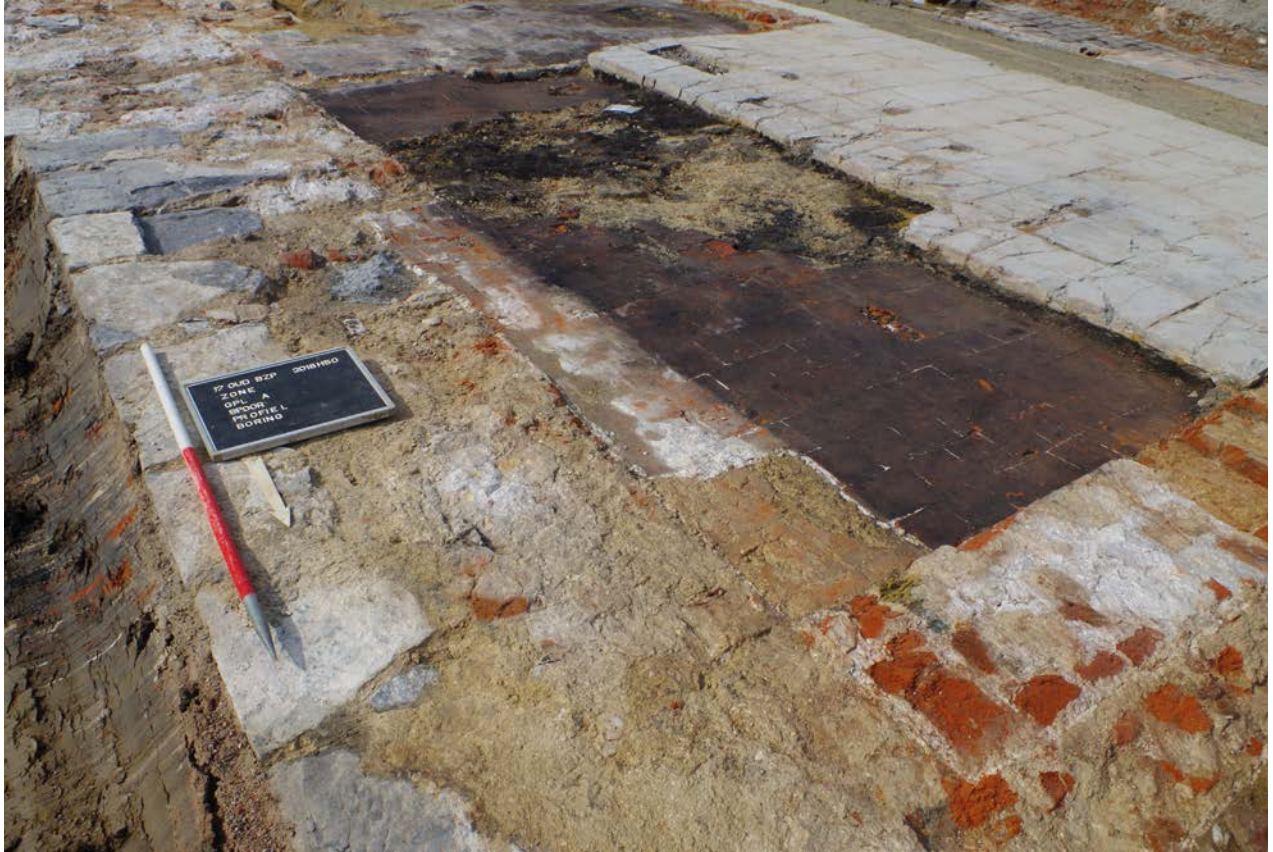
Figuur 70. Vloer C. I-39 is duidelijk verbrand. De uitsparing in de muren is C. I-68.
