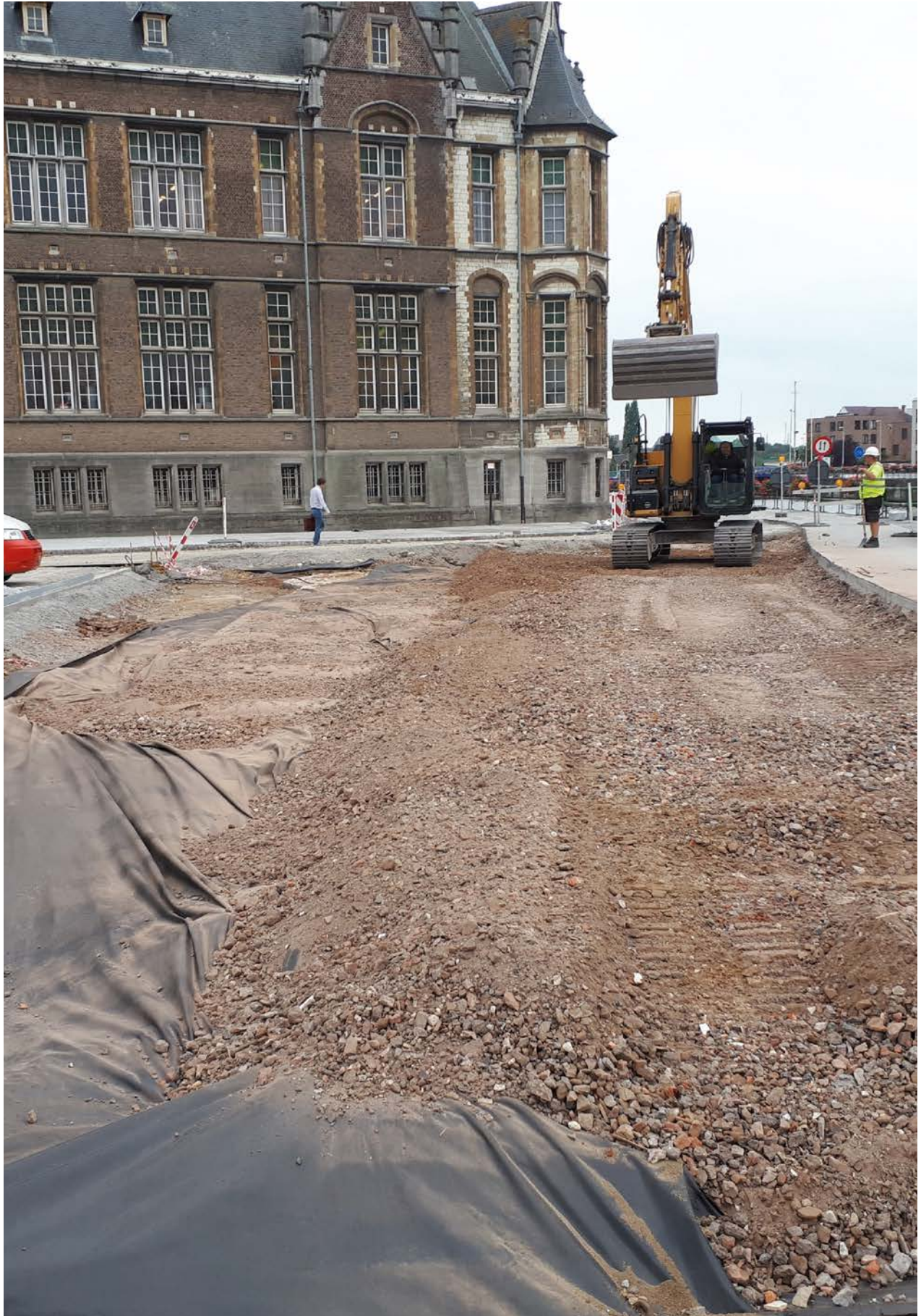
Figuur 48. Opname tijdens de werkzaamheden waarbij de genomen maatregelen ter behoud in situ zichtbaar zijn.
