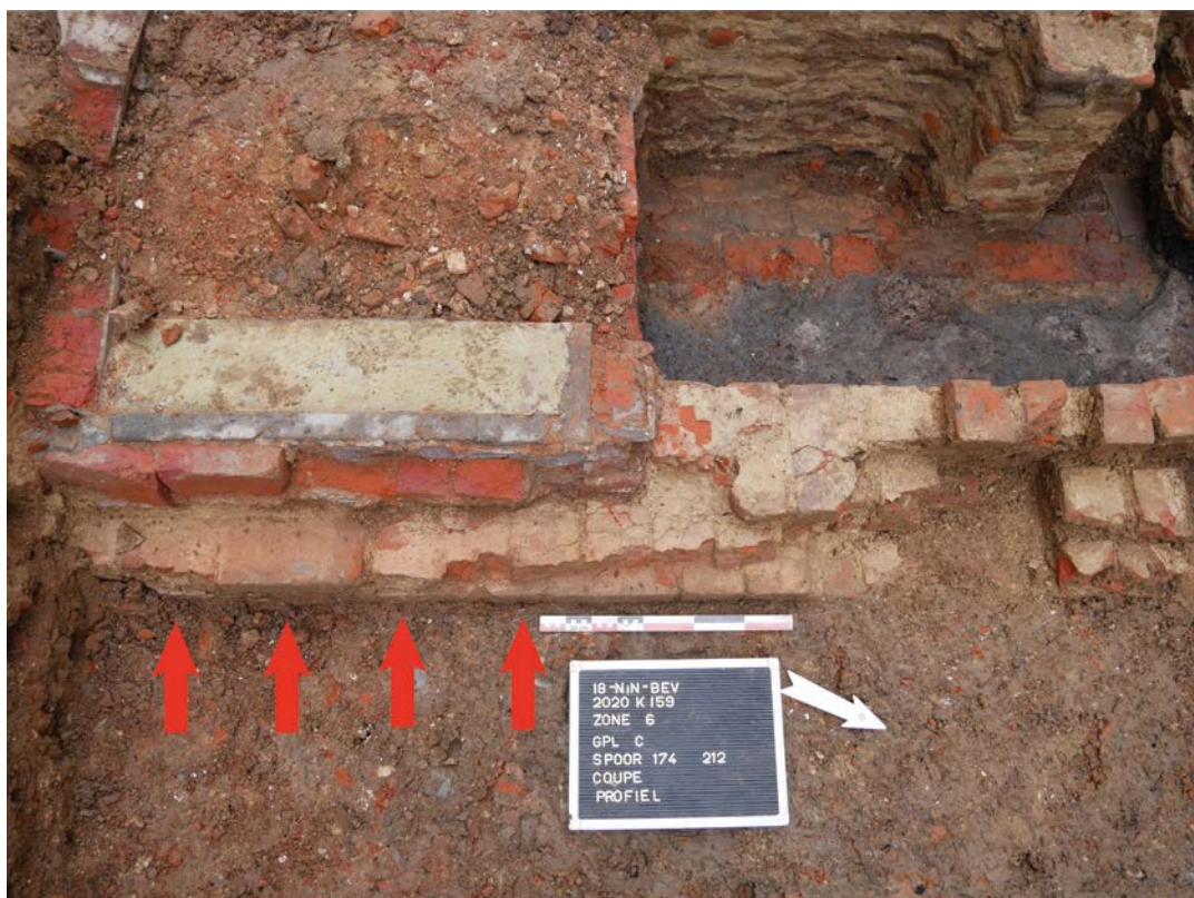
Afb. 25. Detail van de in situ verbrande bakstenen op muur VI-212 op GPL C.
