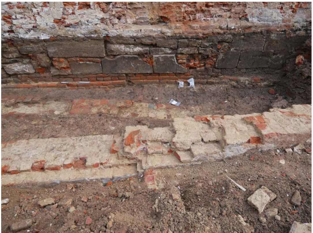
Afb. 54. Detail van de funderingen van de zuidelijke zijgevel.
