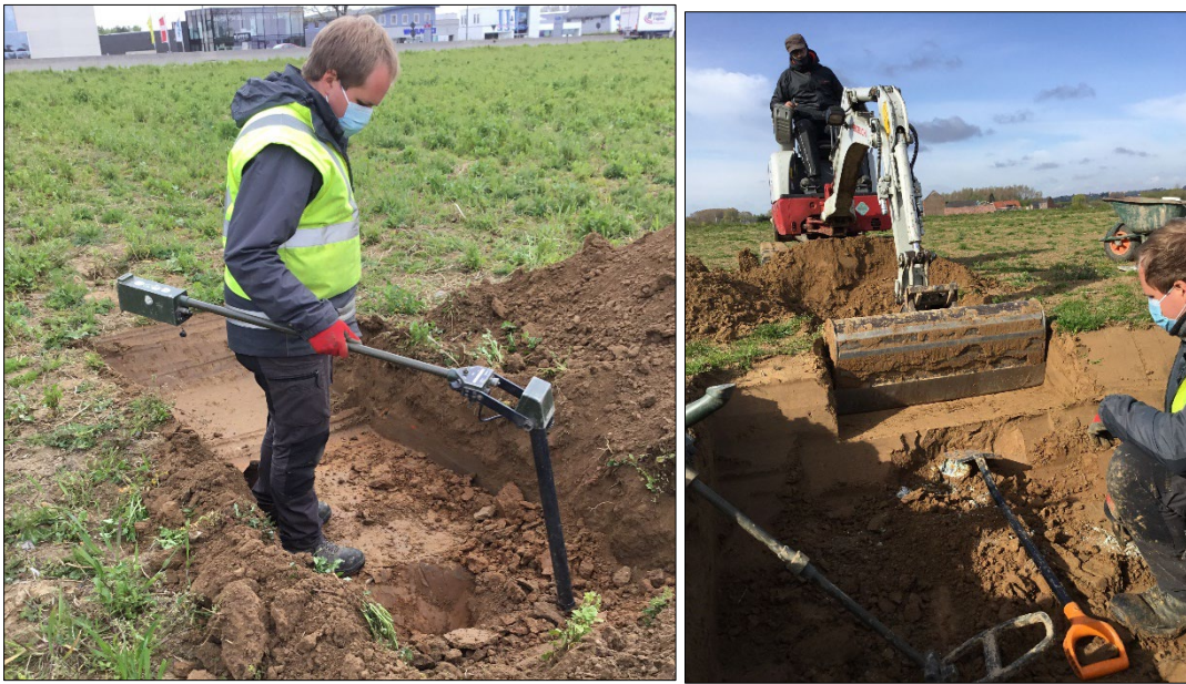
Foto 56 Het opsporen en vrijleggen van potentieel gevaarlijke munitie door een ontmijner van Bom-Be.
