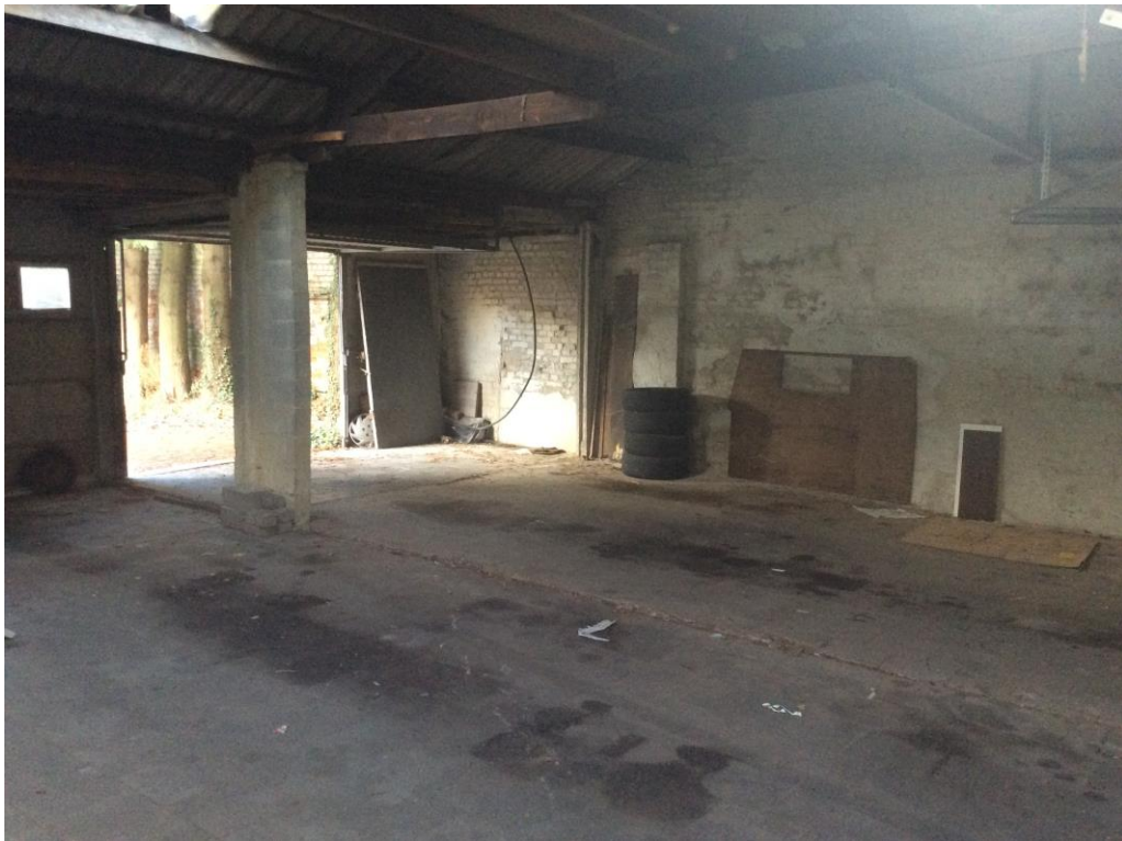
Foto 3: Zicht binnenin garage aan de Kaardeloodstraat.
