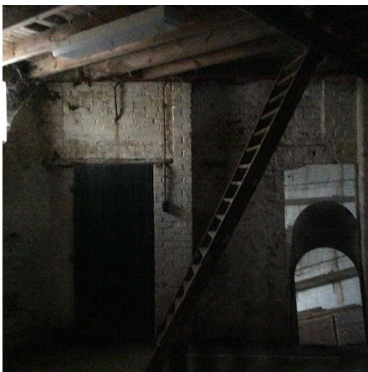
Foto 1: Kelder onder woning in de Beverstraat
