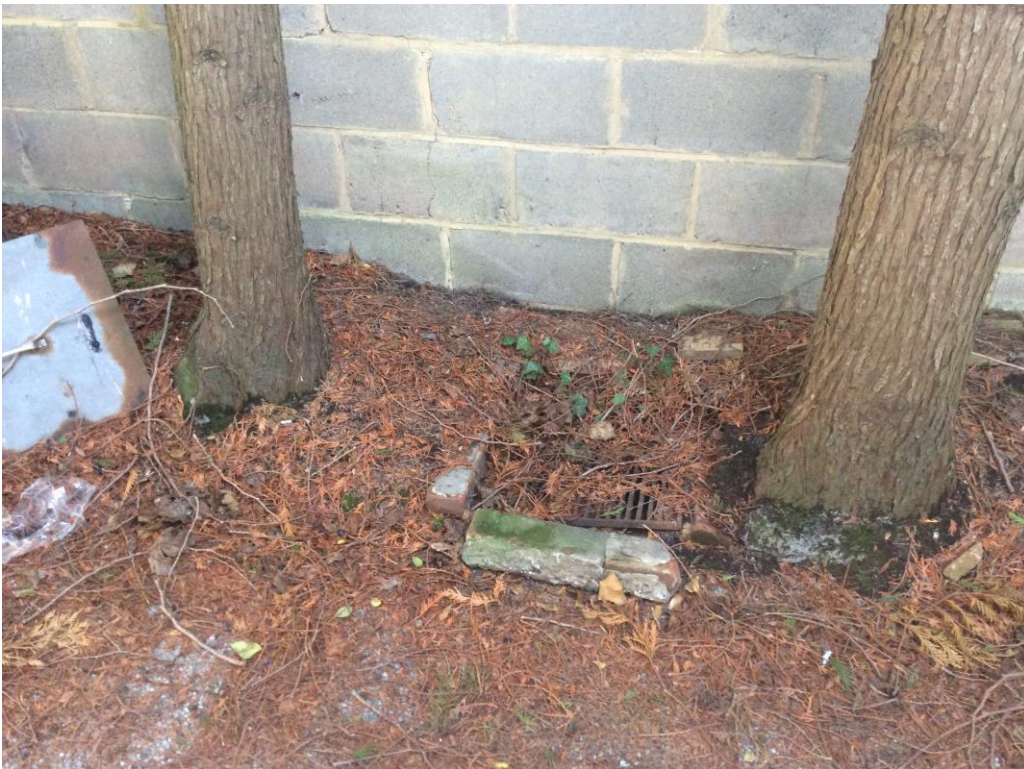
Foto 6: Riolputje aan de zuidelijke grens van het projectgebied, vóór de middelste garage.
