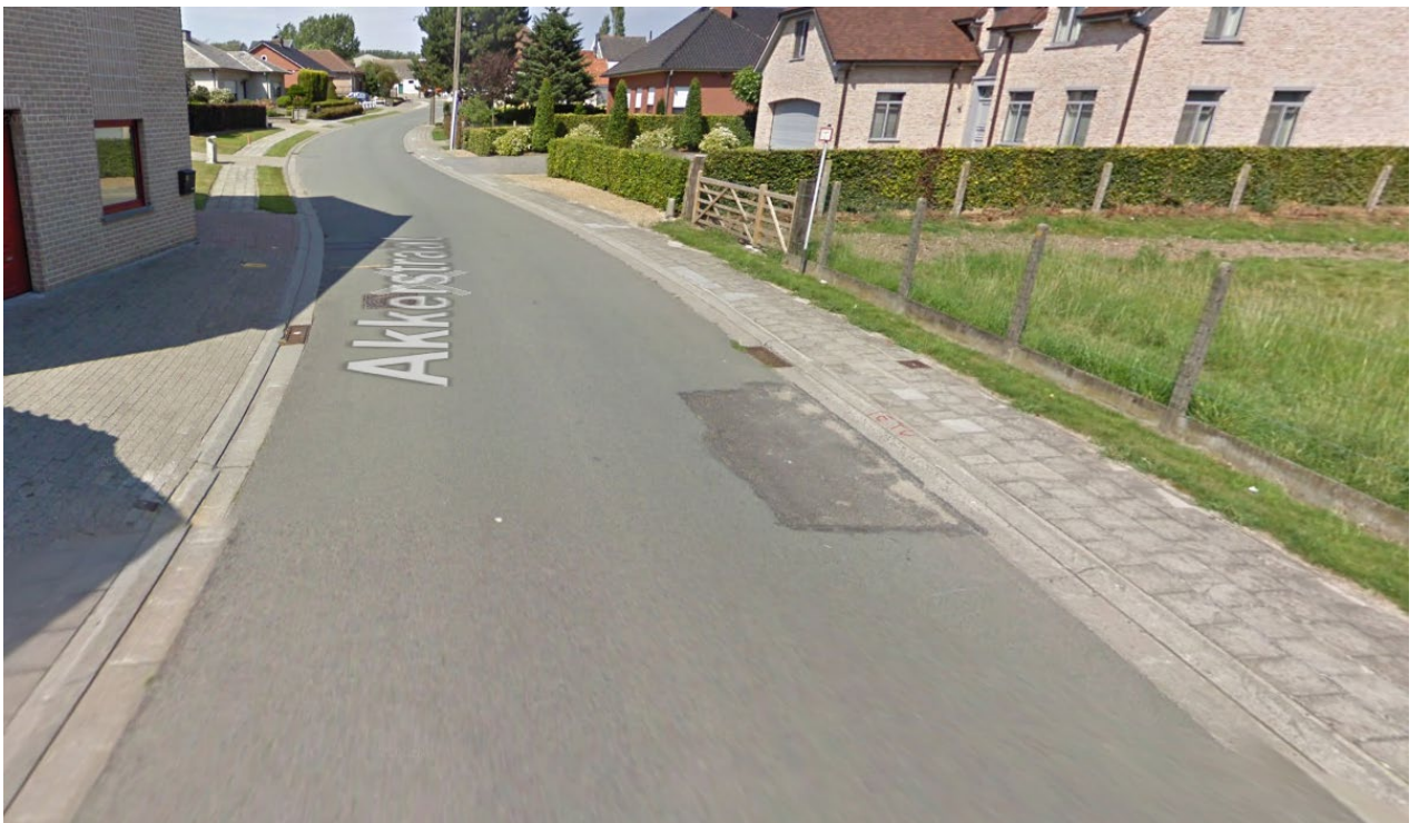
Foto 3 zicht op de Akkerstraat met aan weerskanten afvoerputjes van de bestaande riolering
