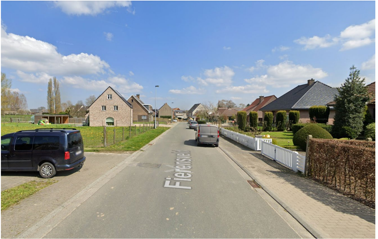
Foto 2 zicht op Fierensveld met aan weerskanten afvoerputjes van de bestaande riolering
