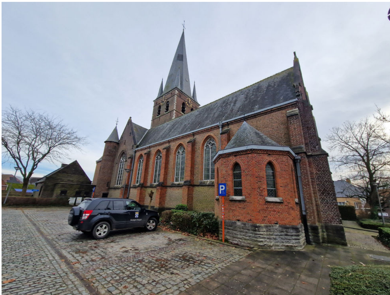
Foto 3. Zicht op de Noordkant van de kerk met de doopkapel. ©SOLVA
