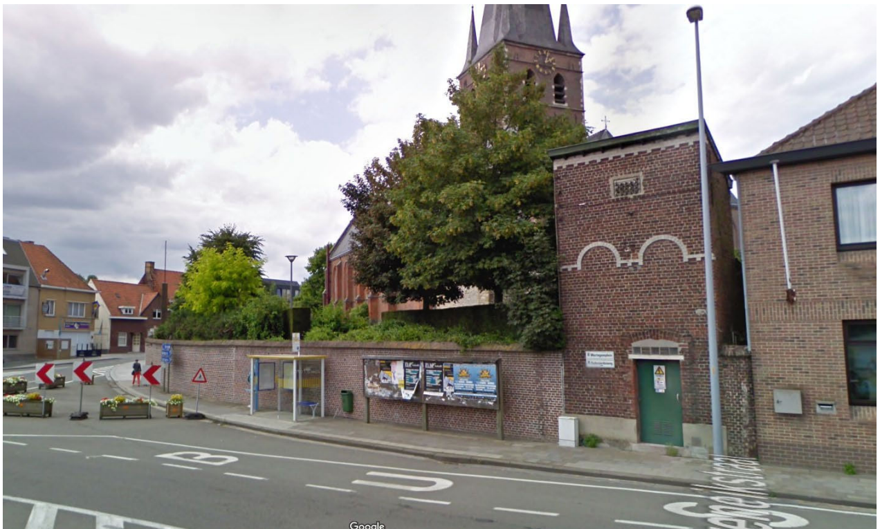
Foto 5. Zicht vanuit het westen op de hoogspanningscabine langsheen de Oudenaardse steenweg.
